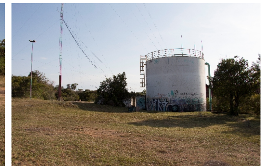
6. Praça e reservatório DEMAE
