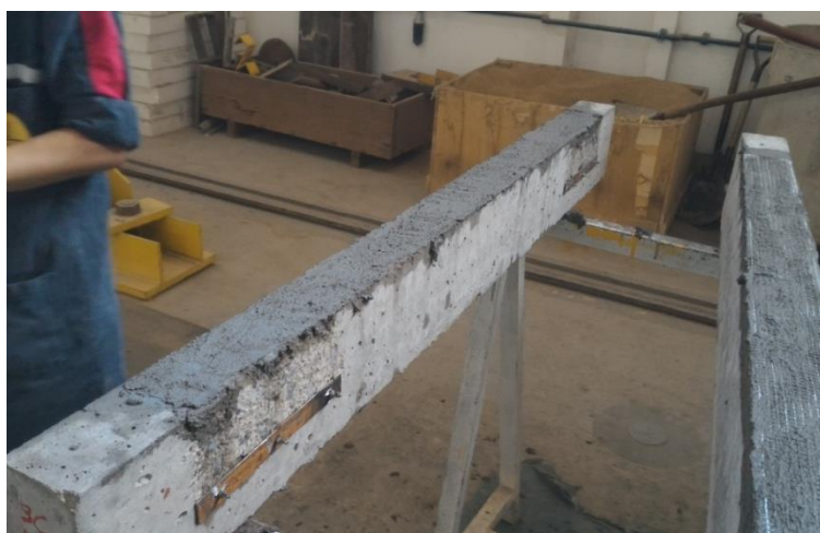
Figura 41: Aplicação do reforço - superfície da viga
