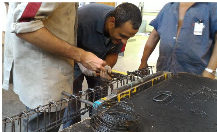
Figura 31: Montagem das armaduras
