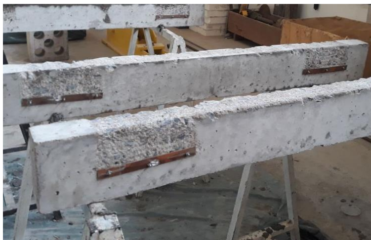
Figura 40 : Aplicação do reforço - superfície da viga
