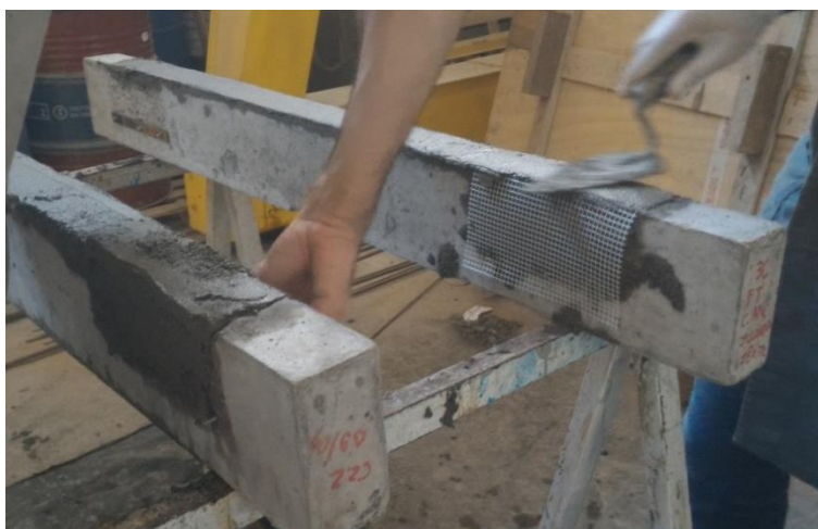
Figura 44: Execução da ancoragem
