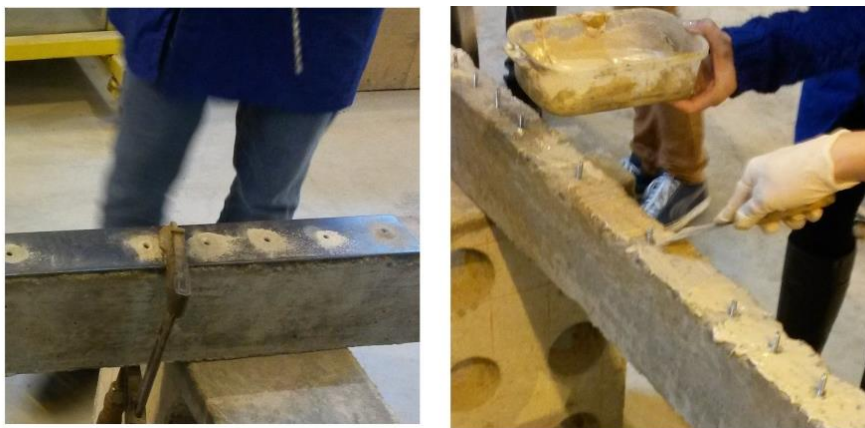
Figura 4: Execução reforço chapa colada
