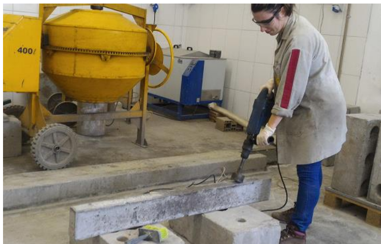
Figura 38: Apicoamento da superfície de reforço
