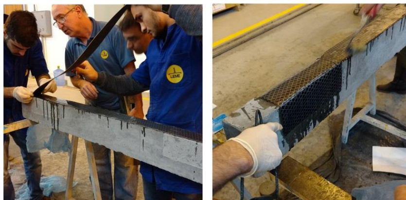
Figura 8: Execução reforço de fibra carbono
