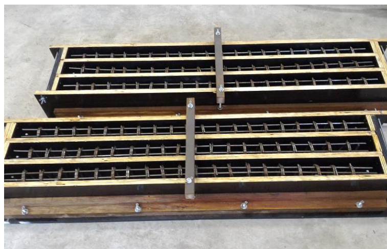
Figura 32: Preparação das fôrmas
