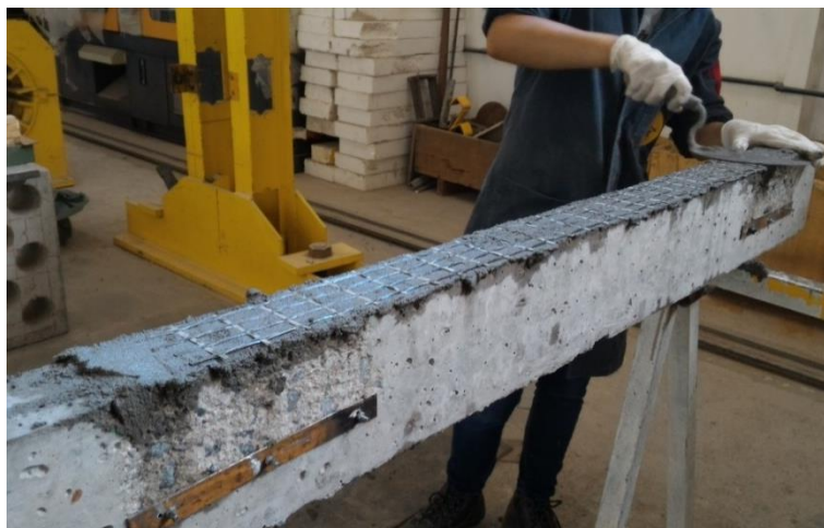
Figura 42: Aplicação do reforço – imersão do têxtil ARMO MESH
