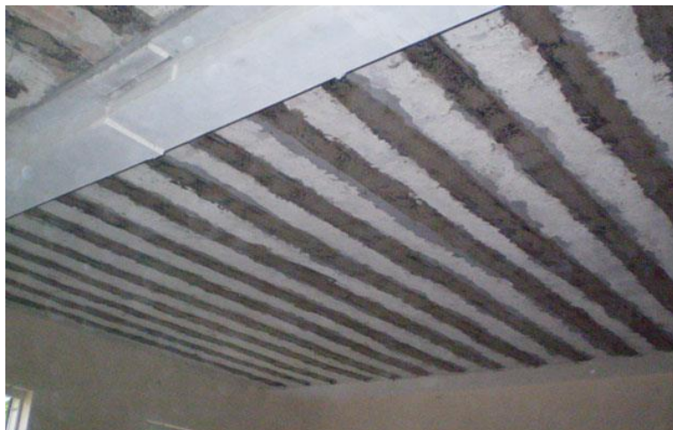
Figura 2: Exemplos reforço fibra carbono
