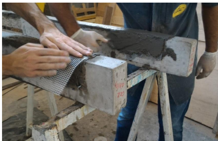
Figura 45: Execução da ancoragem
