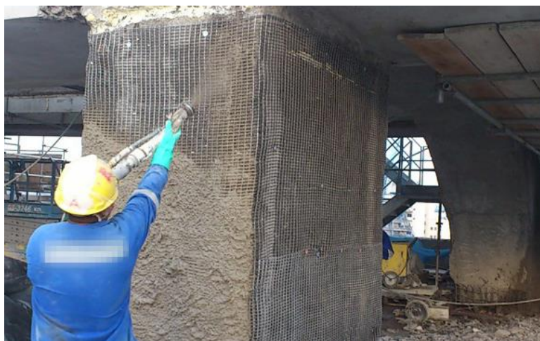
Figura 3: ARMO-MESH na reforma do Maracanã
