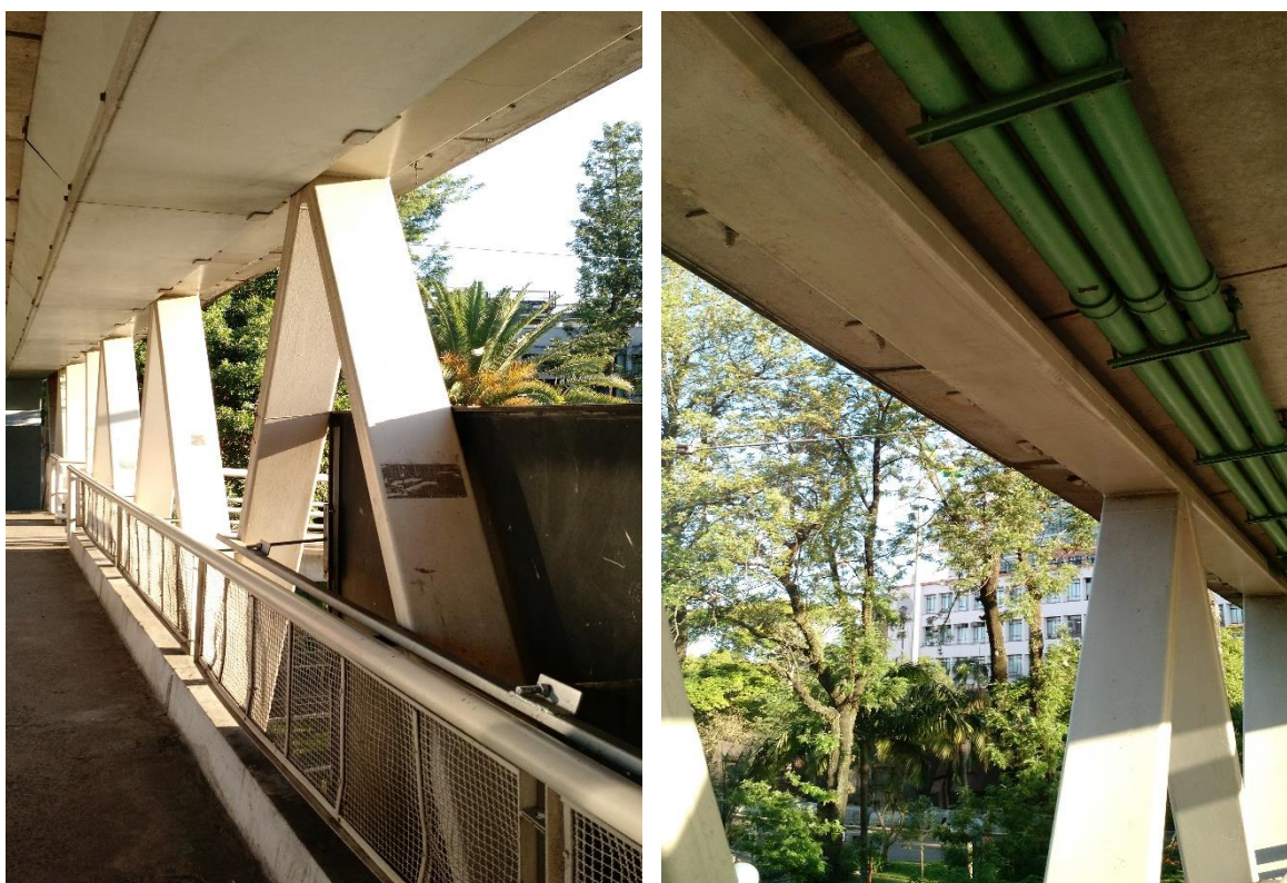
Figura 5 – Ligação das barras diagonais com o banzo superior
