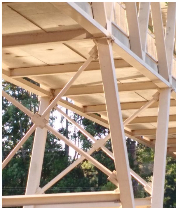
Figura 6 - Parte inferior da passarela e apoios intermediários da passarela da PUCRS Fonte: Fotografadas pelo autor
