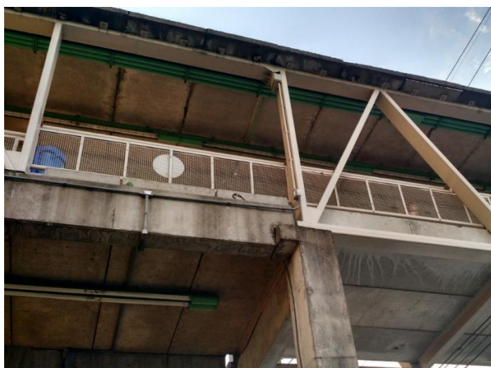
Figura 4 - Estrutura de acesso à passarela Fonte: Fotografadas pelo autor
