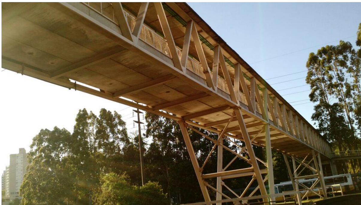
Figura 1 - Passarela metálica da PUCRS
