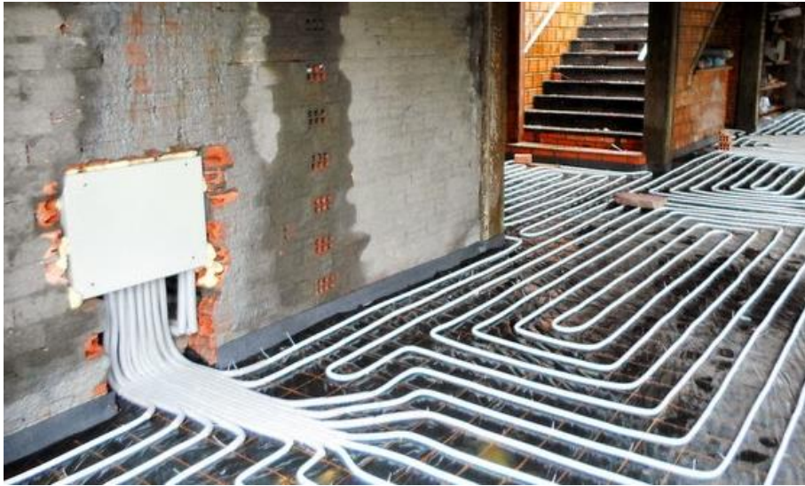
Figura 9 – Exemplo de instalação de piso radiante
