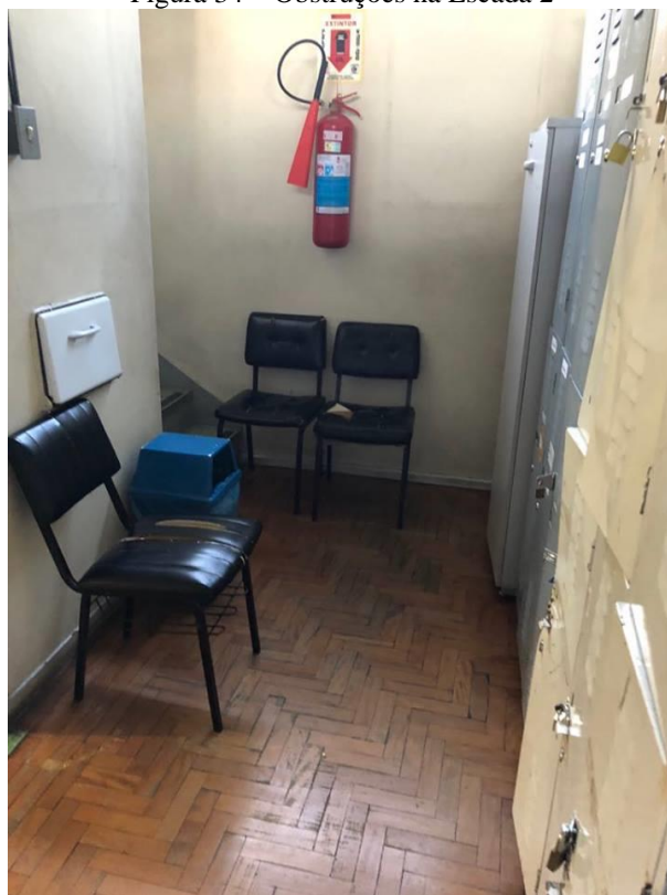
Figura 34 – Obstruções na Escada 2
