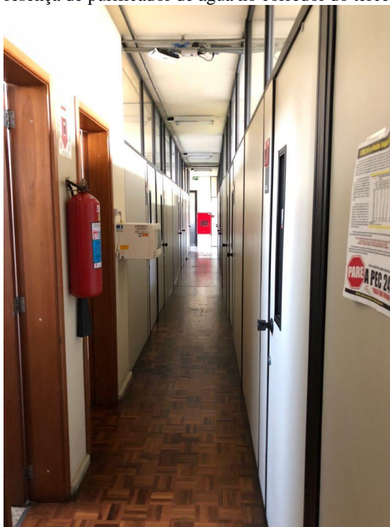
Figura 25 - Presença de purificador de água no corredor do terceiro pavimento
