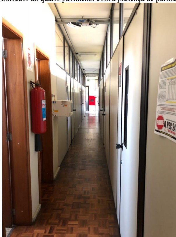
Figura 27 - Corredor do quarto pavimento com a presença de purificador de água
