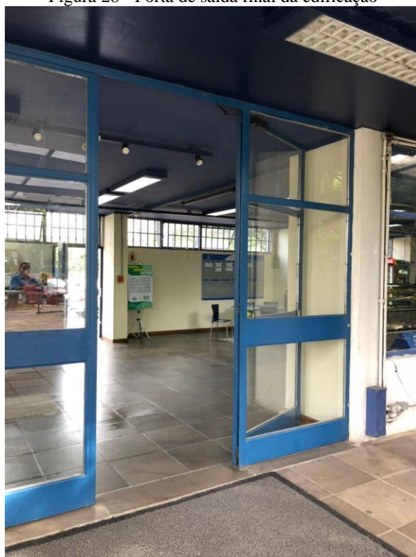
Figura 28 - Porta de saída final da edificação
