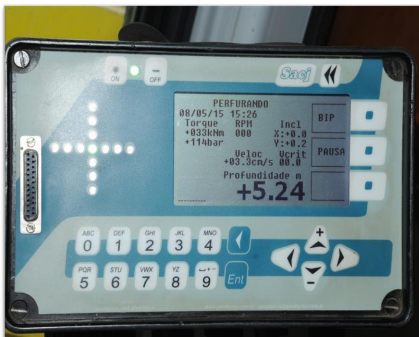
Figura 16 – Monitoramento da perfuração in loco
