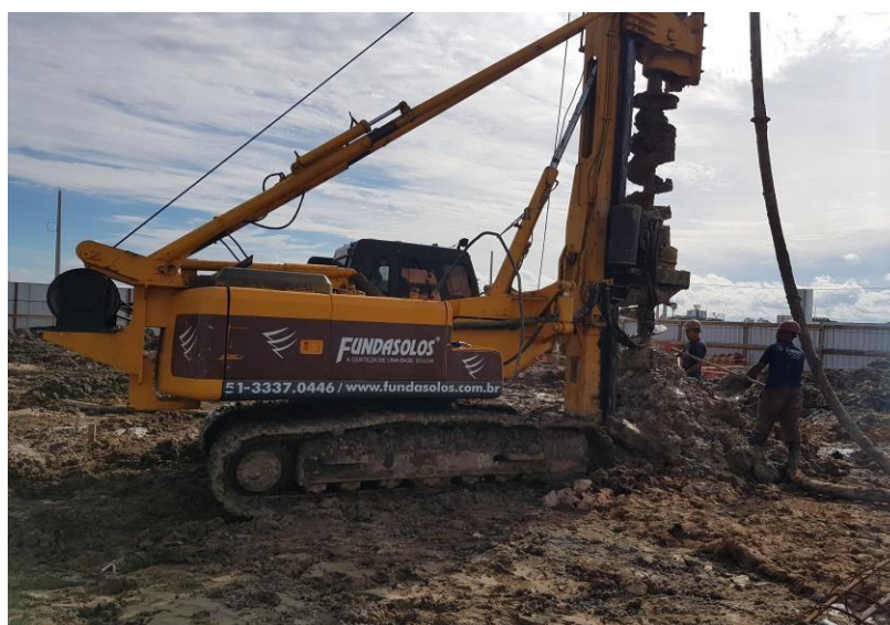
Figura 11 – Concretagem e retirada do material
