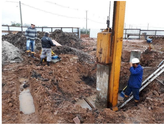
Figura 28 – Execução das provas de cargas
