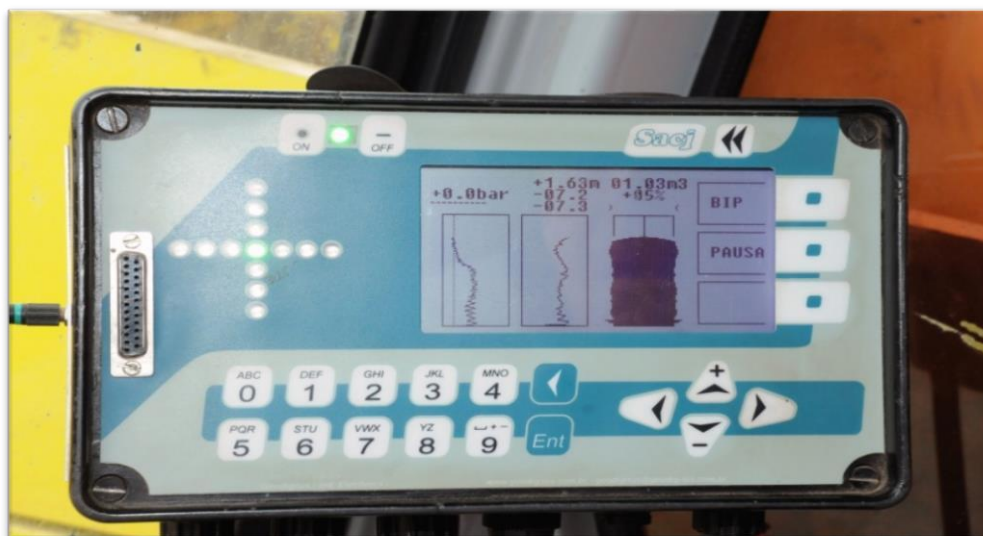
Figura 17 – Monitoramento da concretagem in loco
