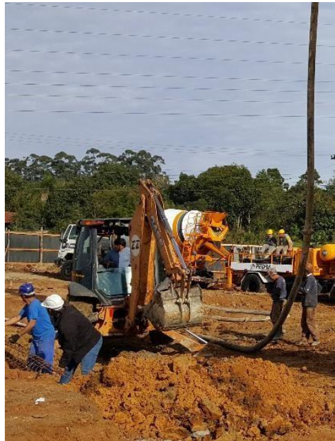
Figura 12 – Retroescavadeira retirando o material
