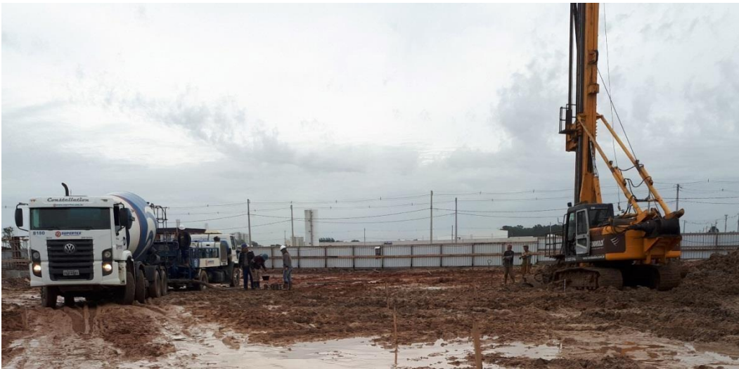
Figura 26 – Execução do Estaqueamento
