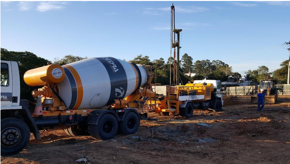
Figura 10 - Concreto e bomba posicionados atendendo ao estaqueamento
