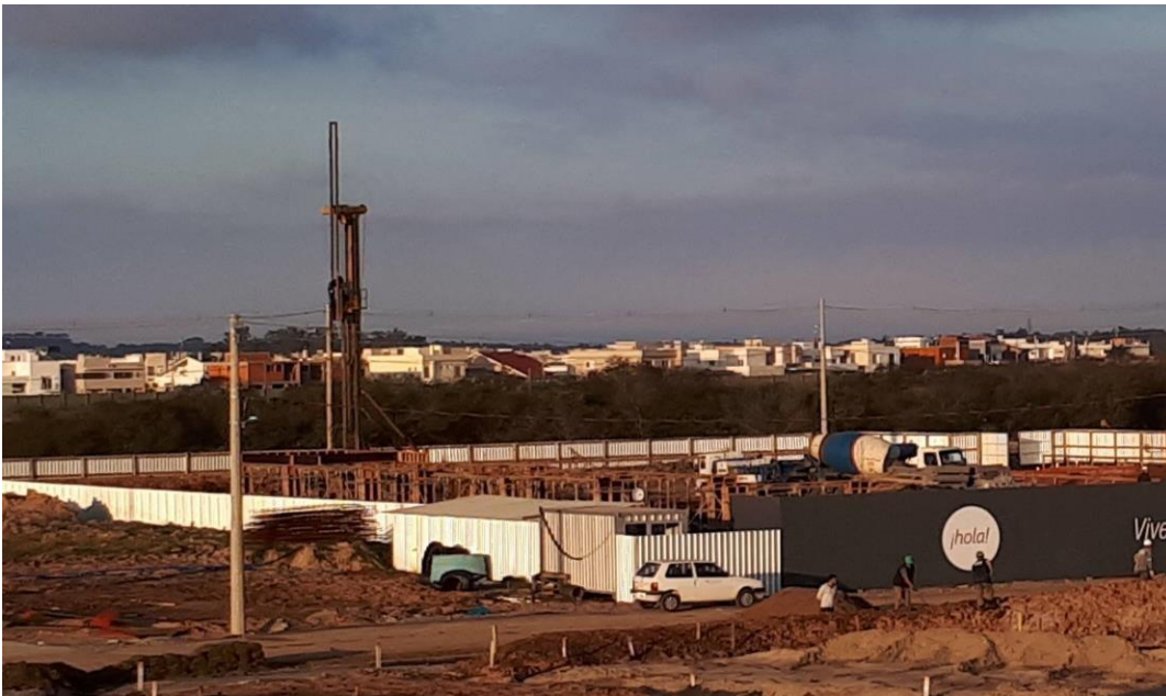
Figura 27 – Execução do Estaqueamento
