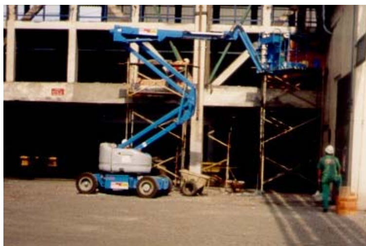
Figura 7.15. Interferência entre atividades criando situação de risco.
