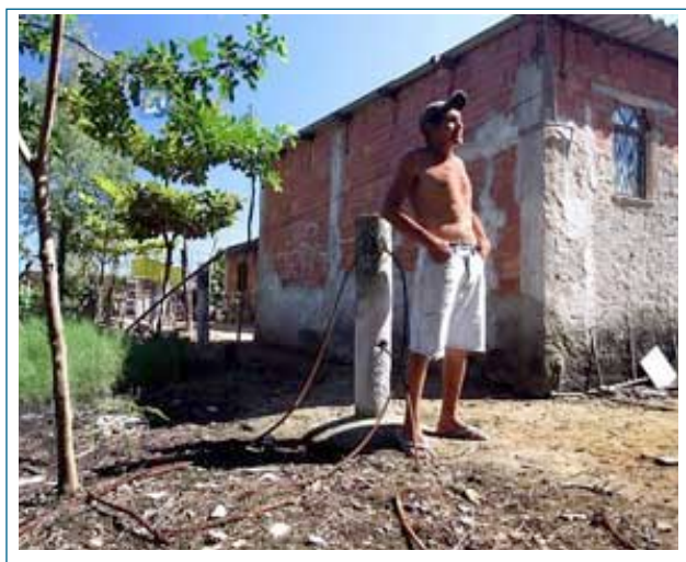
Figura 1 . Cabos de aço e pilares de concreto do projeto de 2001 (Favela do Rio Piraquê, em Guaratiba).
