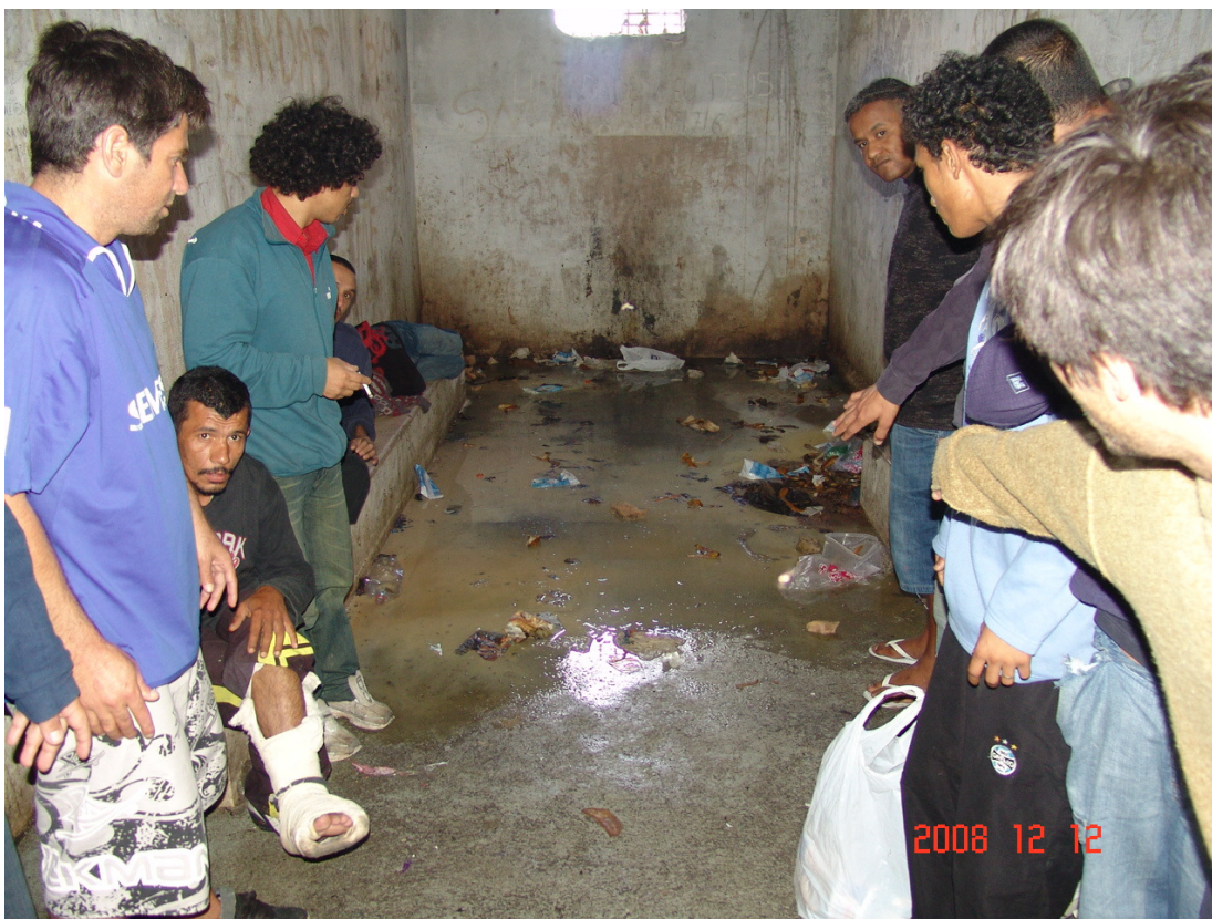
Foto 9: Esgoto transbordando no corredor. Foto fornecida pelo Juiz Sidinei Brzusca.
