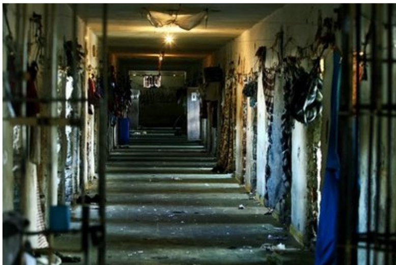
Foto 1: Corredor da terceira galeria do Pavilhão C. Foto realizada pelo fotógrafo do Jornal Zero Hora Daniel Marengo. Disponível em http://provacontato.blogspot.com/search/label/pres%C3%ADdio%20central .
