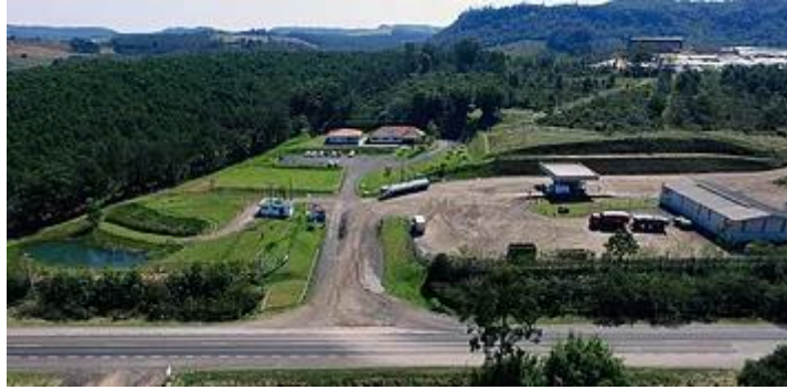
Figura 29: Aterro Sanitário Essencis – Capela de Santana/RS [51]
