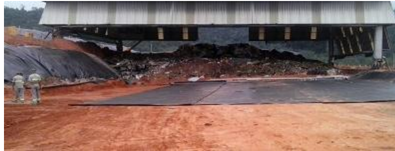
Figura 31: Operação de instalação da nova geomembrana na ampliação da célula de deposição de resíduos [51]
