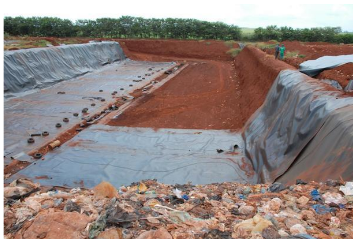
Figura 8: Imagem de um talude com unclinação conforme considerado no desenho esquemático anterior. Talude com inclinação aproximada de 60° graus. [39]
