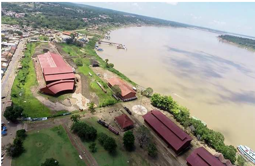
Fotografia 1: Imagem panorâmica da atual Complexo Ferroviário Madeira-Mamoré localizado à margem direita do rio Madeira.
