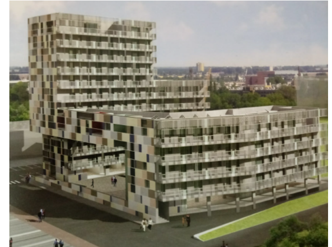
Edifício de apartamentos | Ravenna, Itália, 2006 Cino Zucchi Architectti
