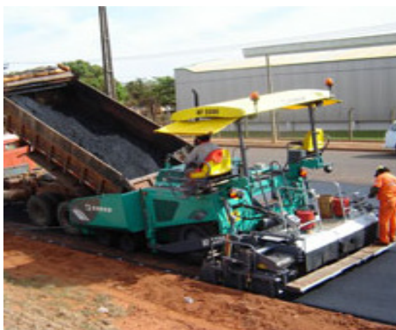
Figura 9 – Acabadora de asfalto
