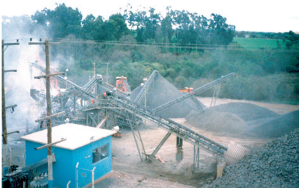
Figura 5 – Vista de uma instalação de britagem
