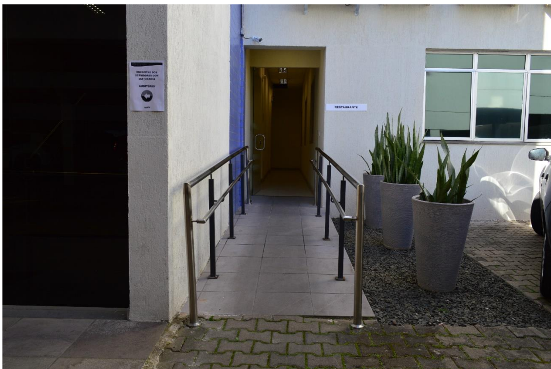
Figura 1 – Rampa de acesso Prédio III
