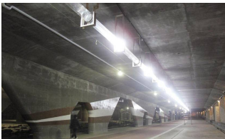
Figura 94 - Duto de luz composto por lentes em Busan - Coreia do Sul
