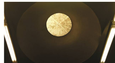
Abertura zenital com fechamento em acrílico
