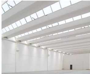
Figura 83 - Abertura zenital tipo shed
