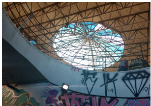
Figura 104 - Abertura zenital na cobertura do Terminal Triângulo
