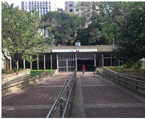
Figura 61 - Acesso a estação Sé
