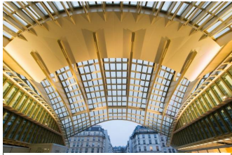
Figura 45 - Vista da cobertura em acesso secundário - Les Halles - Paris
