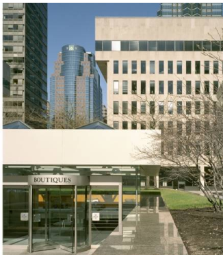
Figura 24 - Acesso ao espaço subterrâneo Place Ville-Marie - Montreal
