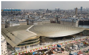
Figura 42 - Vista geral da cobertura envidraçada em construção - Paris
