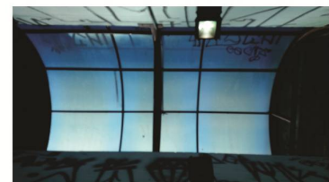
Abertura zenital com fechamento em acrílico
