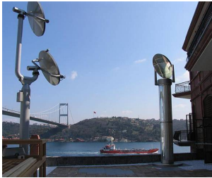
Figura 92 - Guia de luz em Istambul – Turquia: imagem dos coletores
