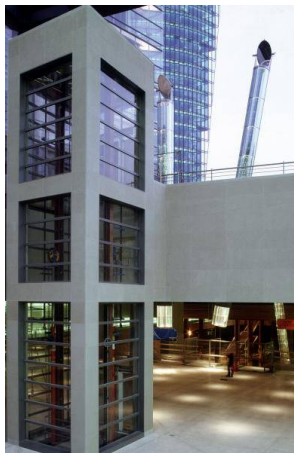
Figura 91 - Dutos metálicos durante o dia
