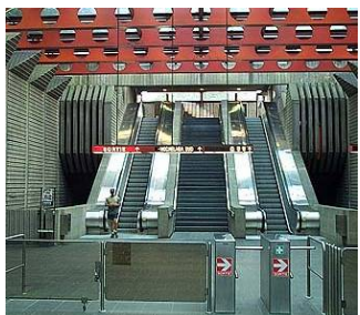
Figura 30 - Estação de metrô Préfontaine - Montreal
