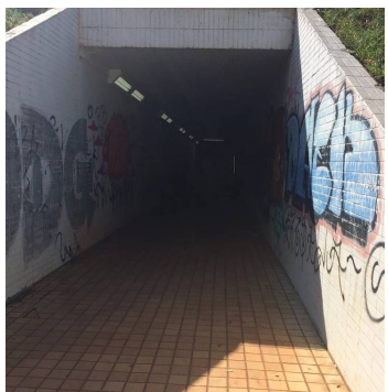
Figura 9 - Passagem subterrânea de Brasília na Asa Norte ligando setor 107 ao 207
