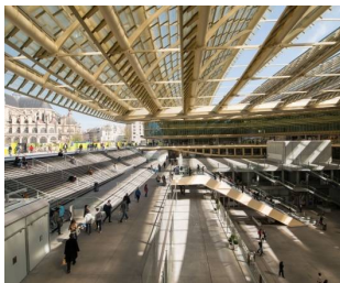
Figura 43 - Detalhes da cobertura Les Halles - Paris
