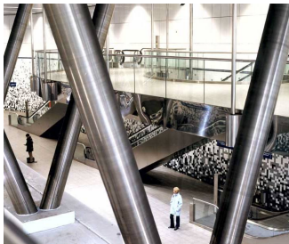
Figura 33 - Revestimento reflexivo da estação
