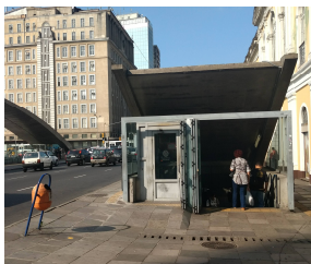
Figura 112 - Acesso à passagem subterrânea da estação Mercado Porto Alegre
