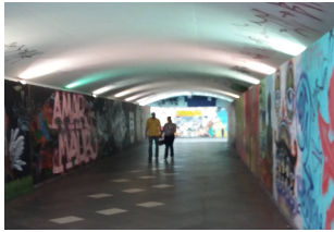
Figura 143 - Passagem subterrânea no Terminal Triângulo
