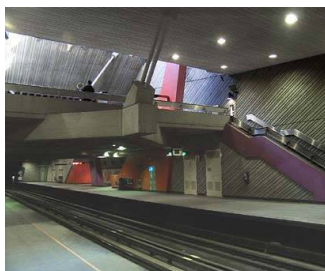
Figura 29 - Estação de metrô La Salle em Montreal
