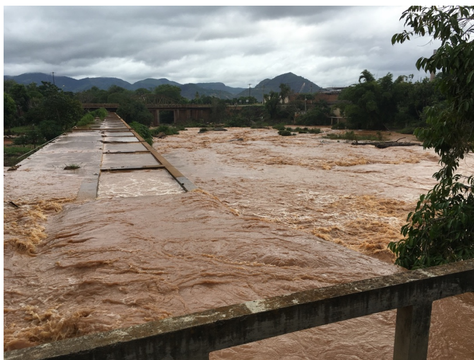
Figura 24 – Calhas desassoreadas e vista do Rio Guandu em direção ao Rio Doce
