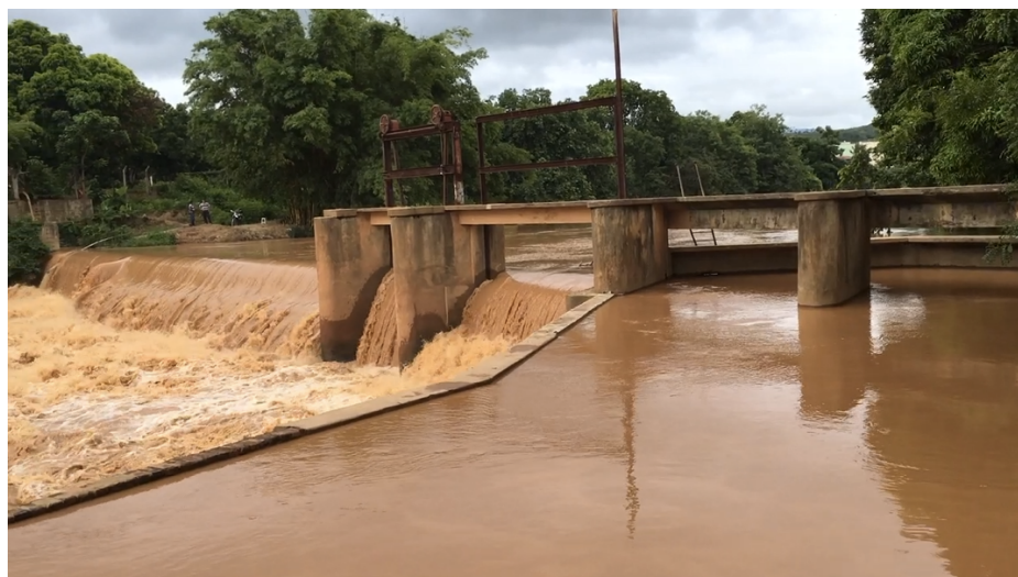
Figura 23 – Estrutura da antiga barragem no Rio Guandu, depois da obra emergencial
