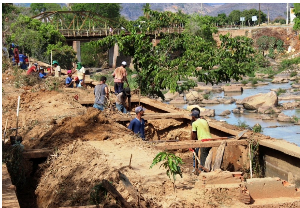
Figura 18 – Trabalhadores desassoreando as calhas no Rio Guandu
