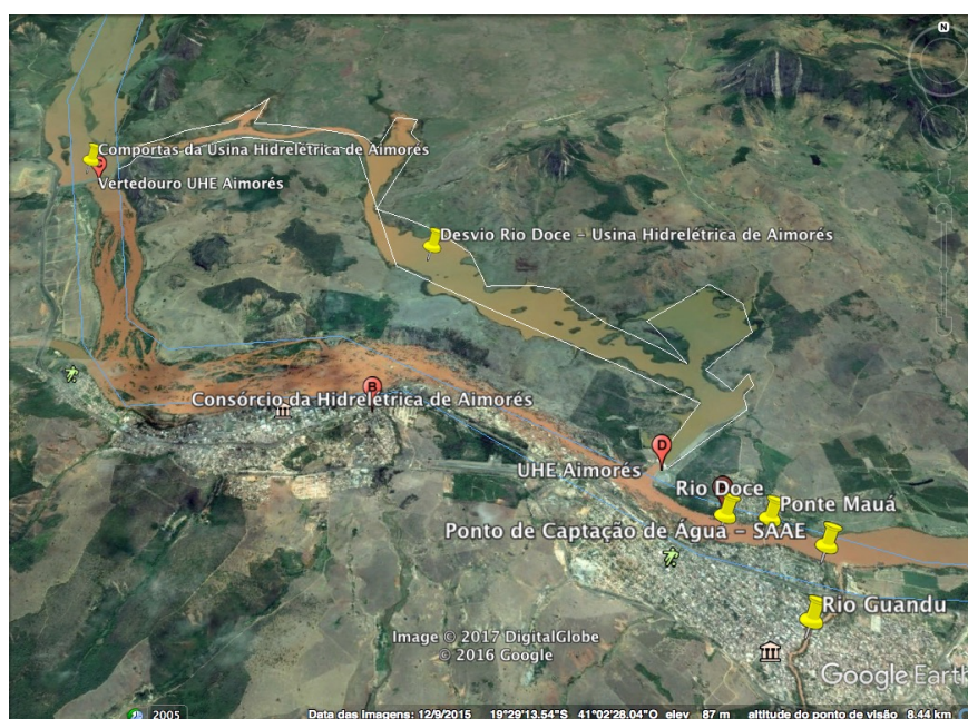
Figura 15 – Usina Hidrelétrica de Aimorés (UHE Aimorés)
