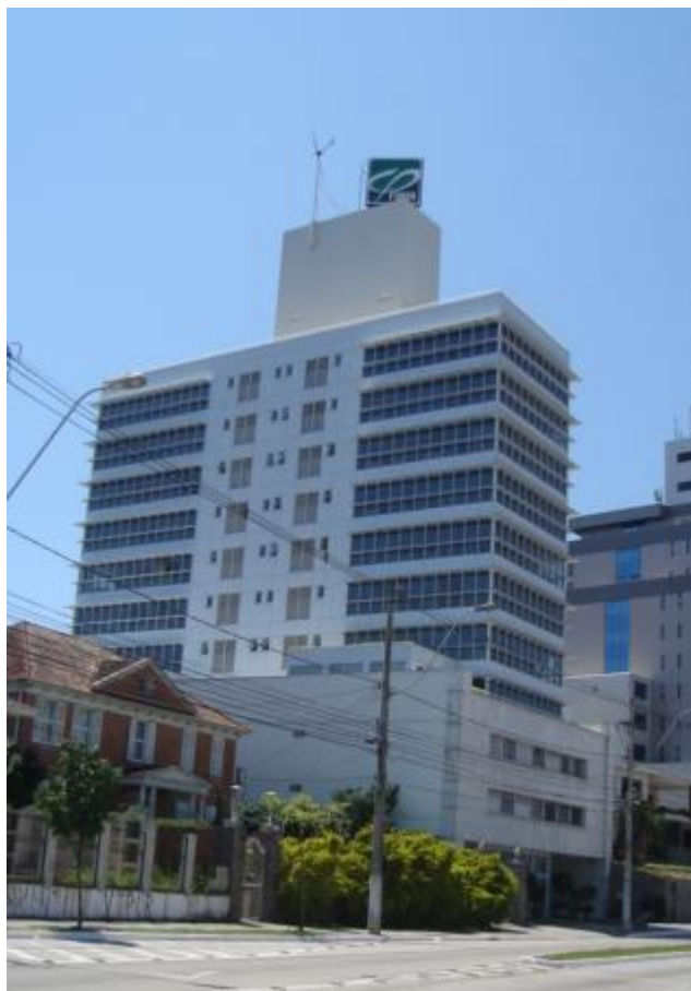
Figura 7 - Fachada do Centro Empresarial Eolis
