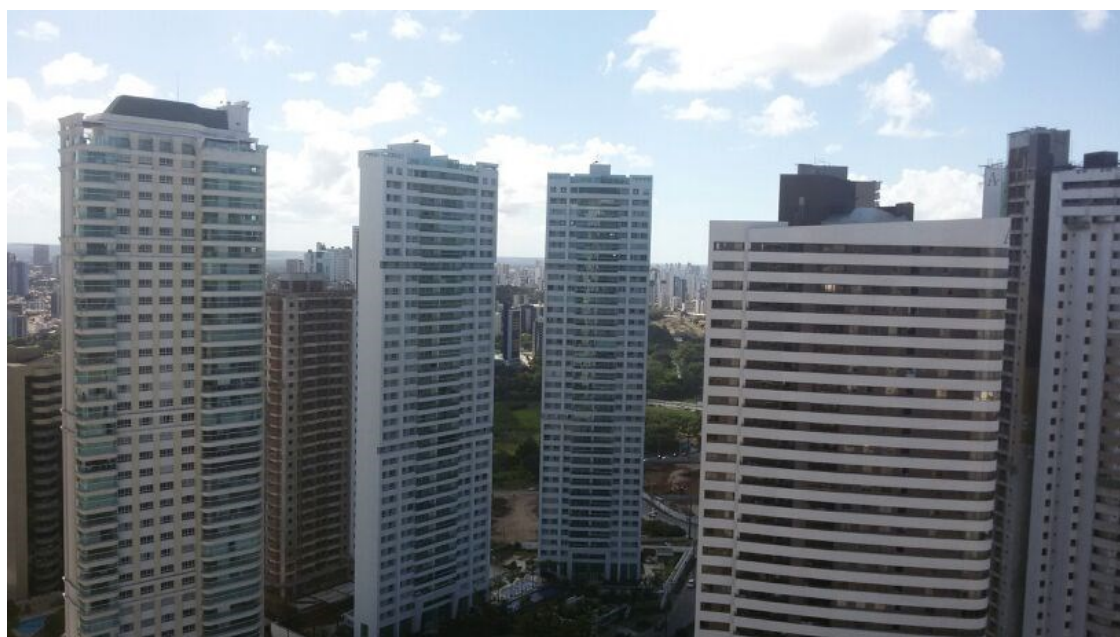
Figura 107: Vista do interior do conjunto de edifícios na área de estudo
