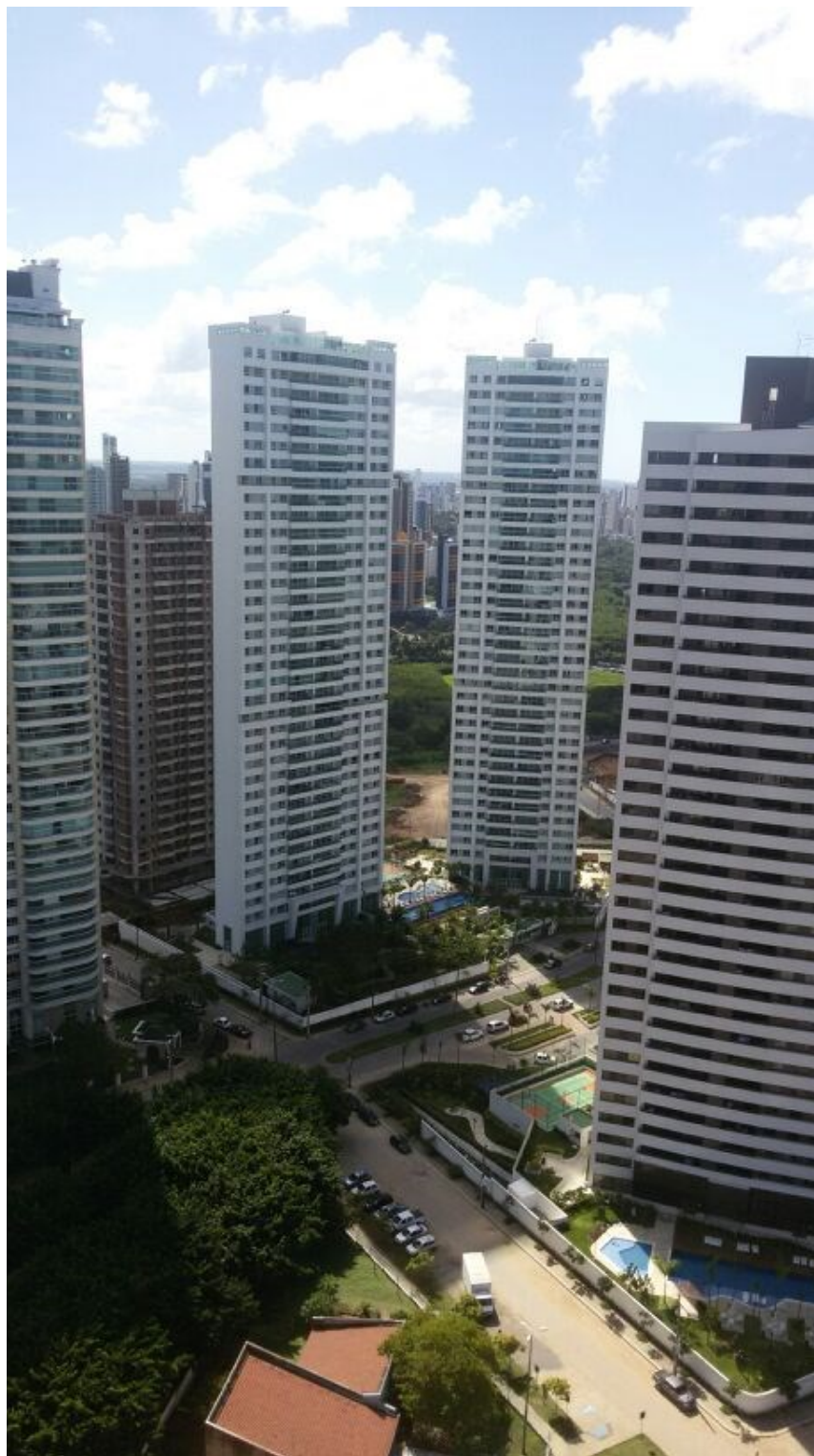
Figura 108: Vista do interior do conjunto de edifícios na área de estudo
