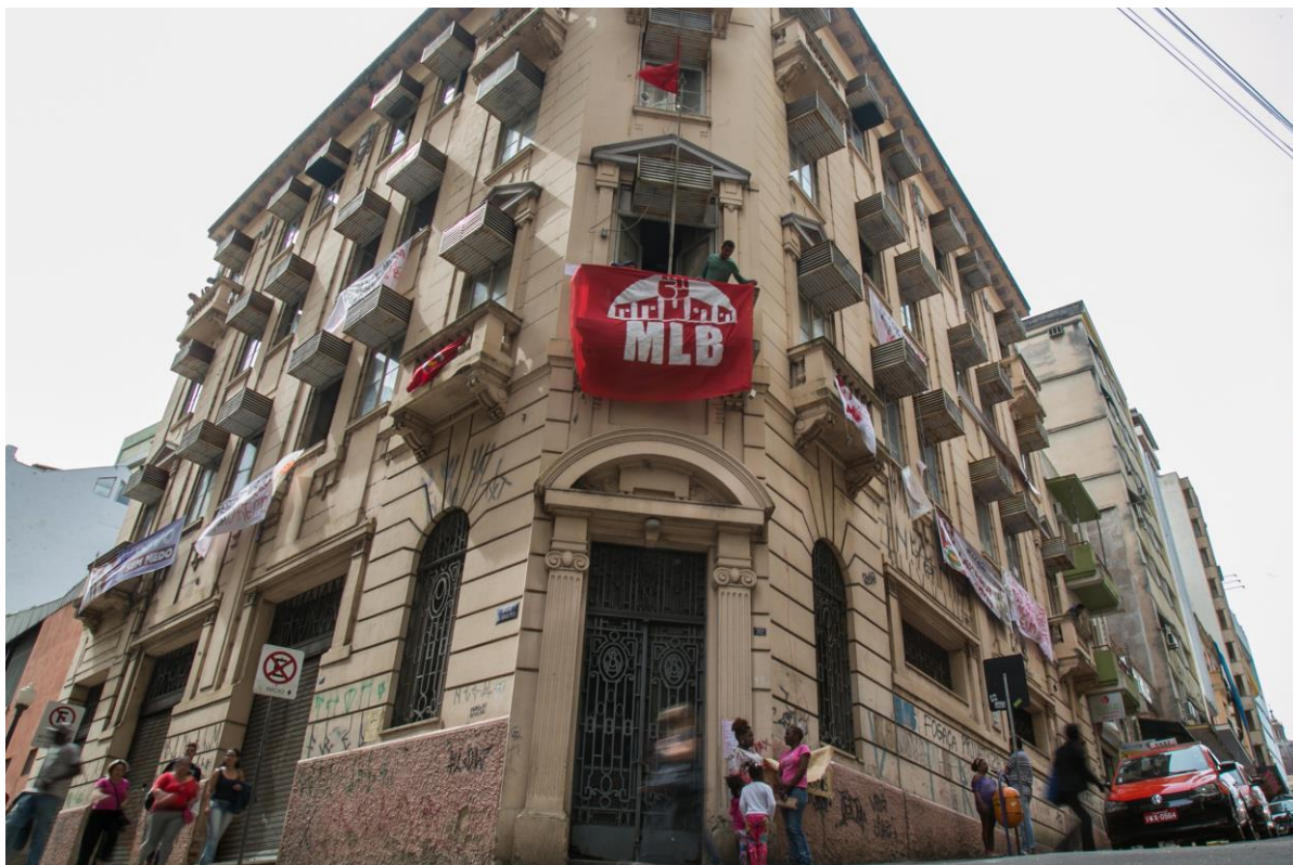
Figura 12 – Prédio da Ocupação Lanceiros Negros
