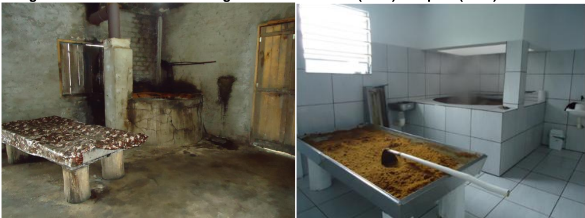
Figura 10 – Estrutura física da Agroindustria H antes (2016) e depois (2017) da reforma
