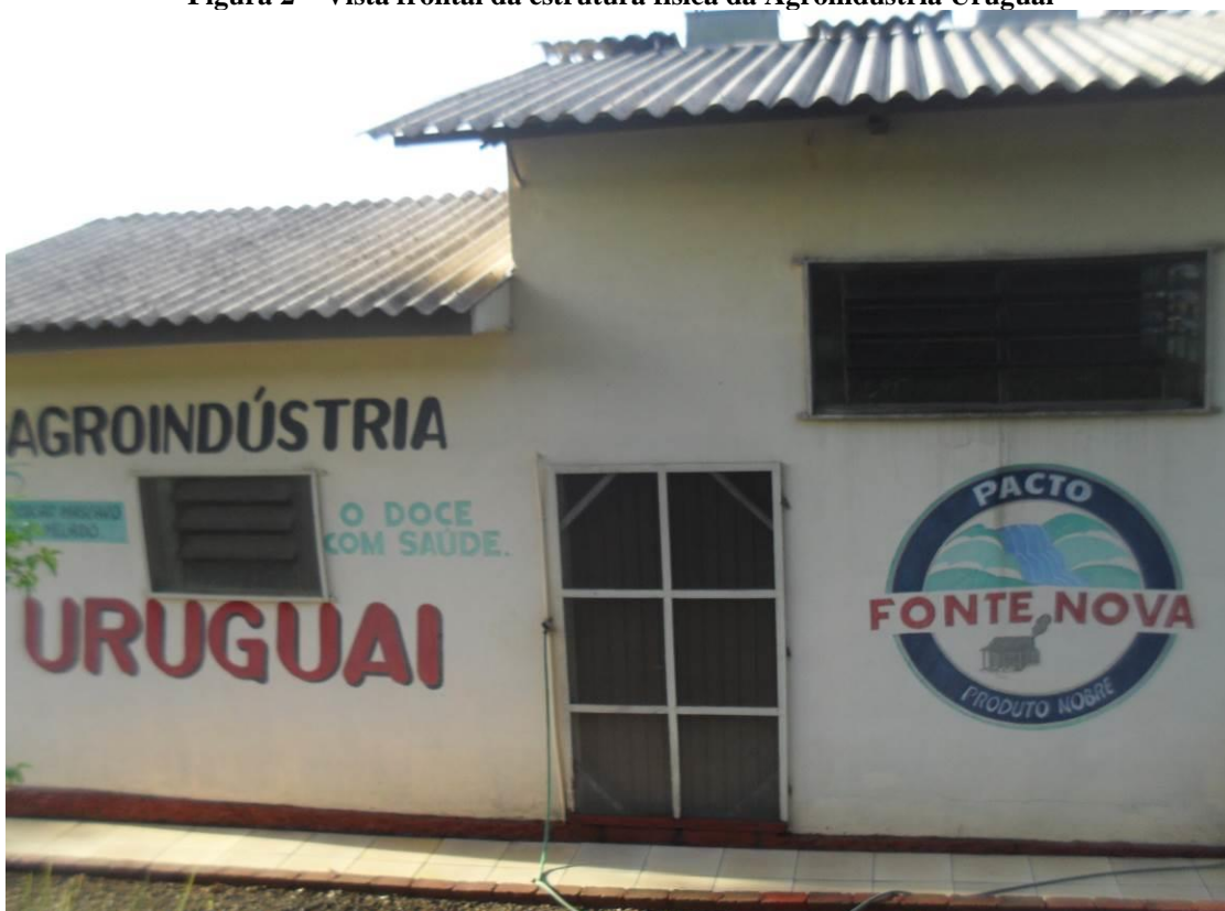
Figura 2 – Vista frontal da estrutura física da Agroindústria Uruguai
