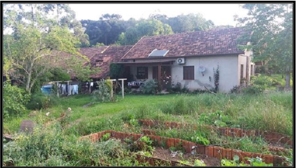
Figura 3 – Sistema Solar de Aquecimento de Água para Atendimento de Residência Rural
