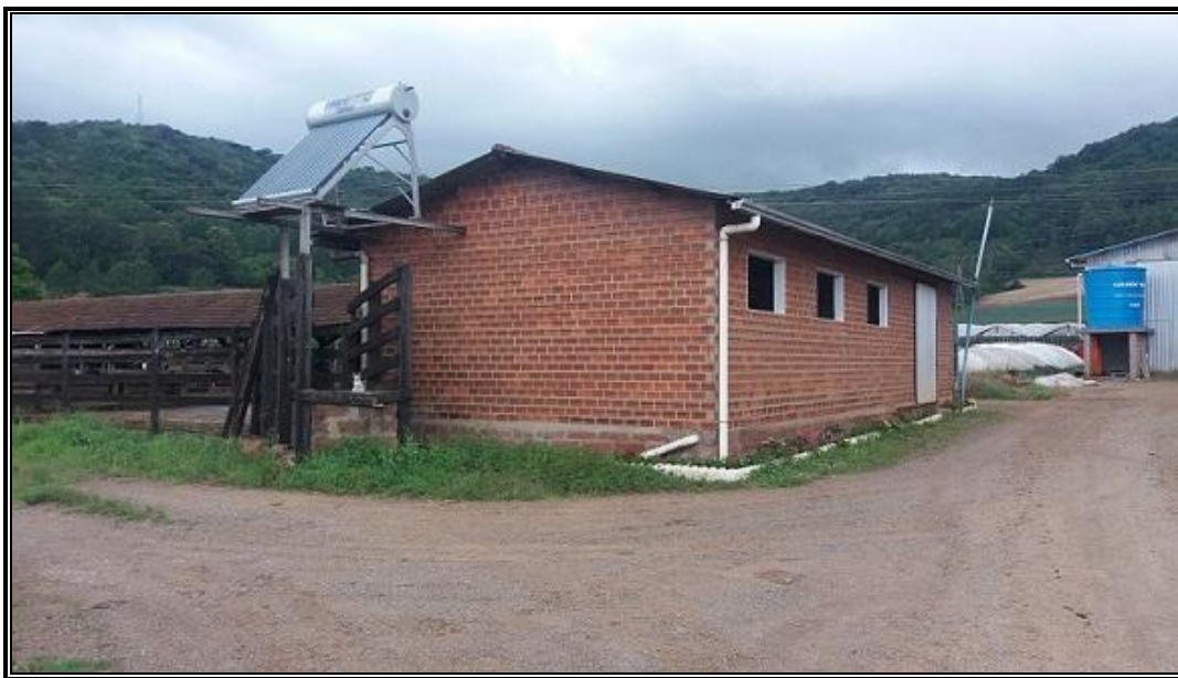
Figura 4 – Sistema Solar de Aquecimento de Água para Sala de Ordenha
