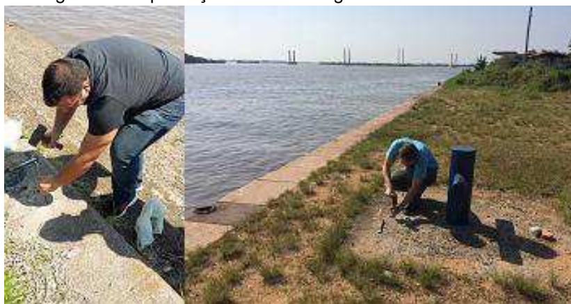
Figura 11 - Implantação dos marcos geodésicos na Patromoria
