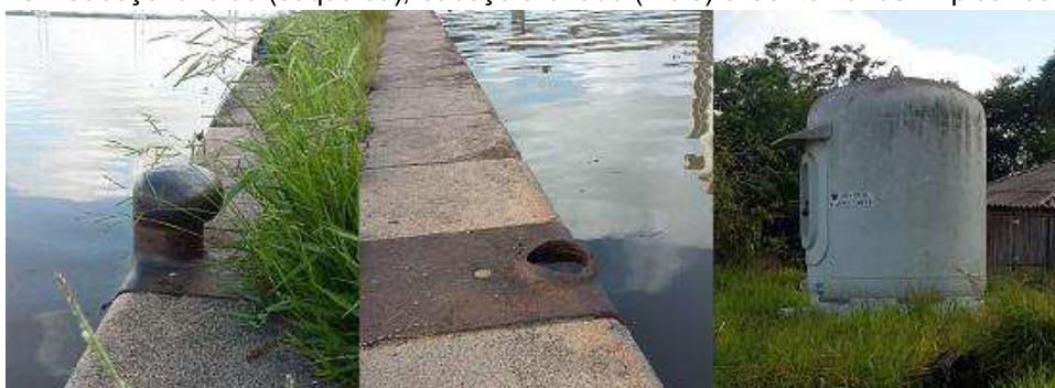
Figura 23 - Cabeço fundido (esquerda), cabeço avariado (meio) e Contêiner de Explosivos (direita)
