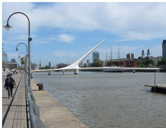
Figura 1 - Revitalização do Porto Madero (Argentina)
