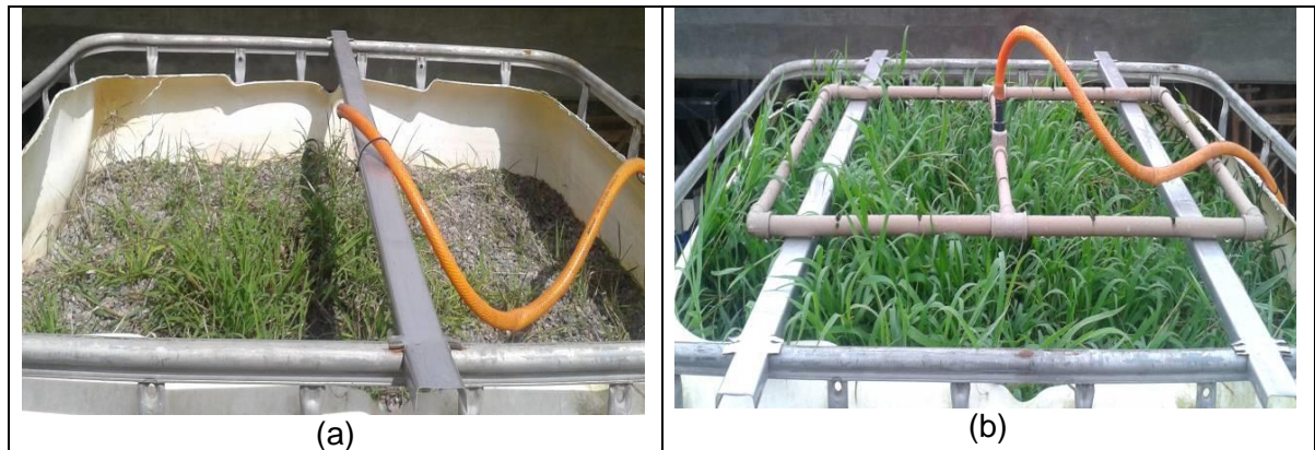
Figura 5.22 Primeiro banhado do BC FSS vertical com a planta L. peruviana no B1, antes (a) e após (b) a instalação dos distribuidores de superfície.
