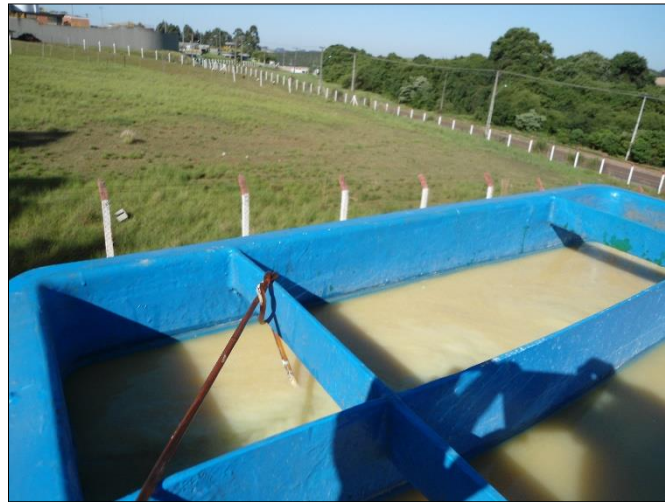
Figura B1- Caixa de coagulação com chicanas.
