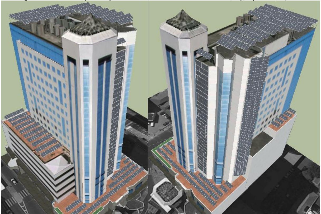
Figura 27 - Vistas da representação em 3D com módulos instalados nascer (esq.) e poente (dir.) solar
