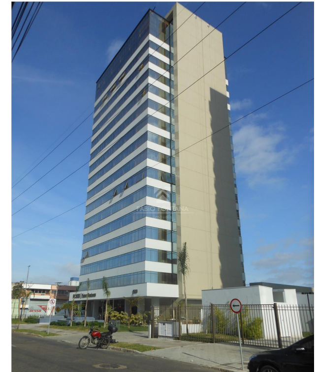
Vista da torre comercial "Rossi Corporate"
