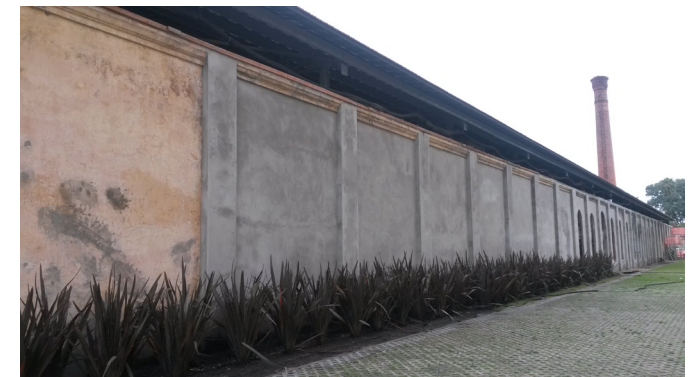
Vista da FIATECI a partir do estacionamento residencial
