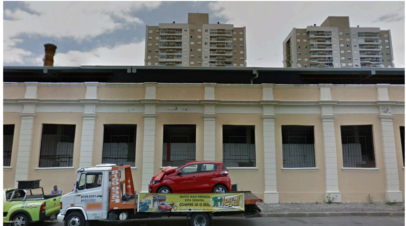
Alteração da fachada original da fábrica da FIATECI para comportar estacionamento: último pavimento foi elevado com estrutura pré-moldada.
