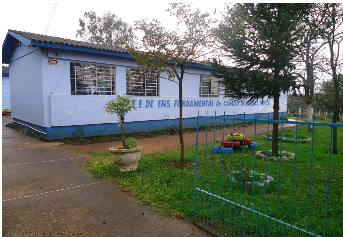
Figura 2: Fachada Frontal da Escola Estadual de Ensino Fundamental Drº Camilo de Freitas Mércio
