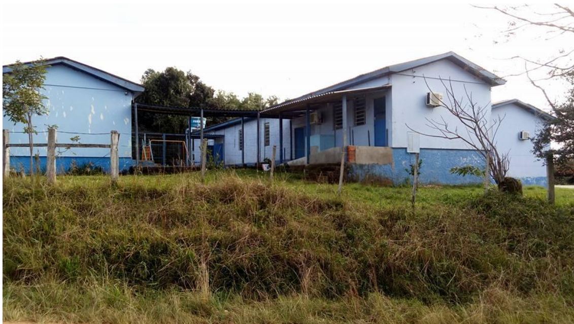
Figura 3: Fachada Lateral da Escola Estadual de Ensino Fundamental Drº Camilo de Freitas Mércio
