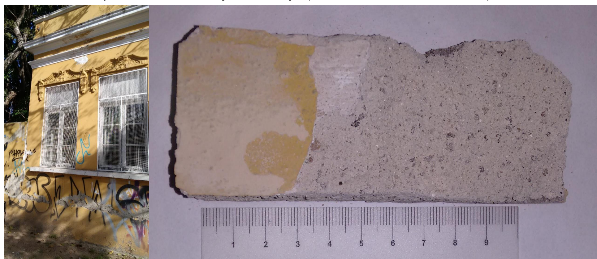
Figura 1 – Fachada do prédio SAERGS e amostra do revestimento da fachada utilizada para a reconstituição de traço (GIORDANI; GUERRA, 2017)
