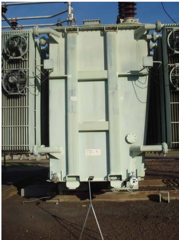
Figura 6.2 – Medição de ruídos no TR 1 (SECI-Canoas)
