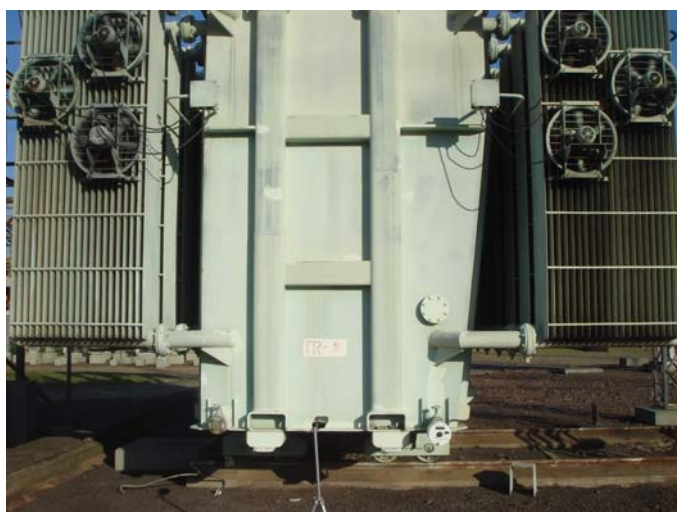
Figura 6.3 – Medição de ruídos no TR 1 (SECI-Canoas)
