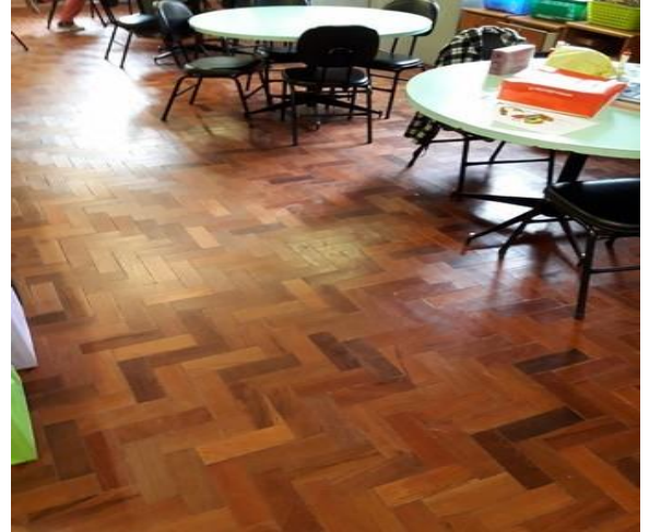
Figura 14: Piso tipo "Parquet"
