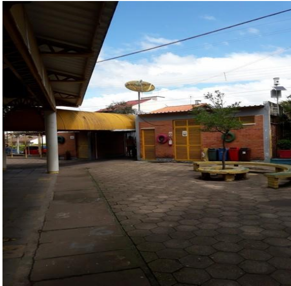
Figura 5: Entrada para o bloco A da EMEF PAT
