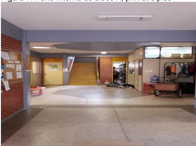
Figura 7: Parte interna do bloco A, primeiro piso
