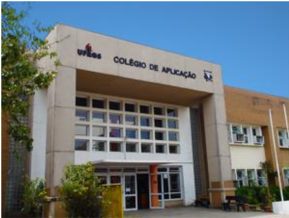
Imagem 01 - Colégio de Aplicação, fachada externa. Disponível em:
