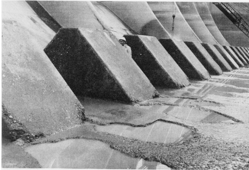
Figura 1.2 - Danos provocados pela ação da macroturbulência na bacia de dissipação de energia da Barragem de Bonneville nos Estados Unidos. Fonte: Lopardo et al. (2006).
