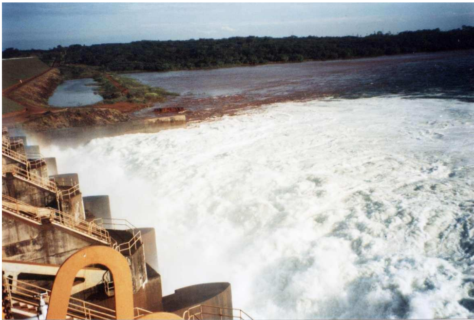
Figura 3.3 - Ressalto hidráulico formado na UHE de Porto Colômbia, vazão de 4000 m 3 /s.
