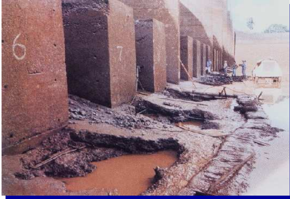
Figura 1.3 - Danos provocados pela ação da macroturbulência na bacia de dissipação de energia da Barragem de Porto Colômbia no Brasil. Fonte: ICOLD/CBDB (2002).
