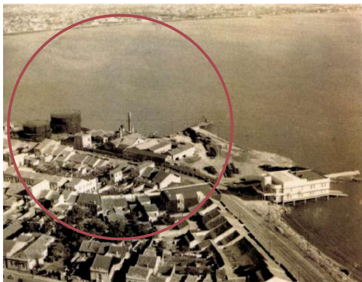
Vista aérea, após as reformas de José Montaury de 1909. Fonte: IPHAE
