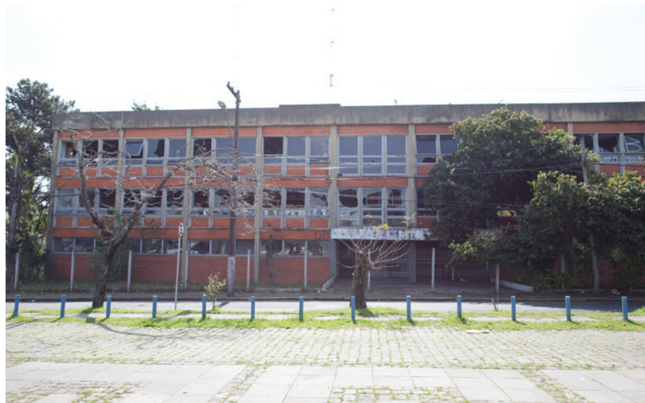
12 Fachada sul do edifício administrativo
