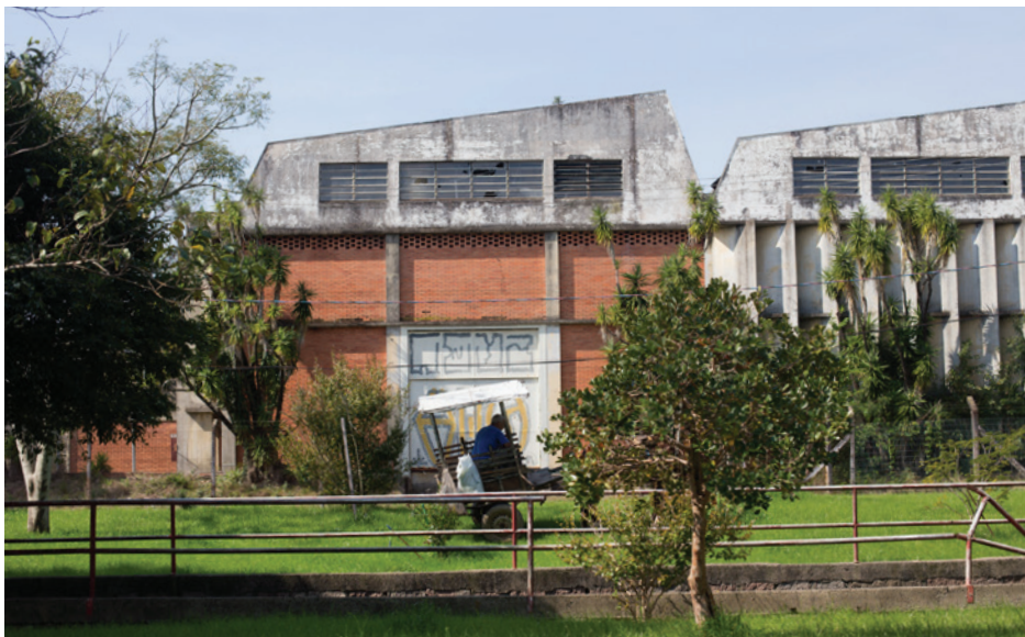
03 Variação de vedação na fachada oeste
