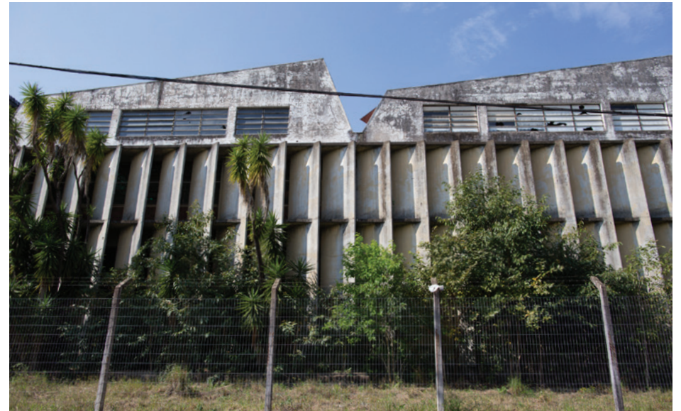
02 Brises de concreto aparente da fachada oeste
