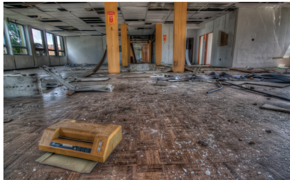
15 Interior do edifício administrativo Crédito: Mozart lochims
