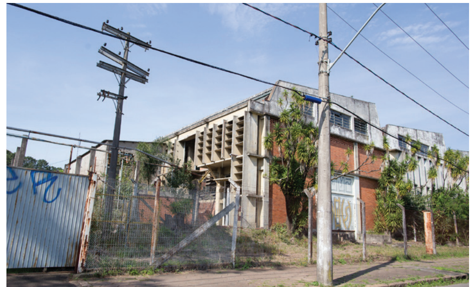
04 Brises verticais e horizontais na fachada norte
