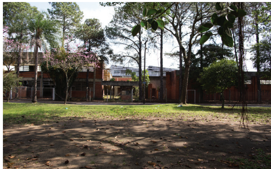
24 Canteiro central da Av. Carneiro da Fontoura com entrada principal do complexo ao centro
