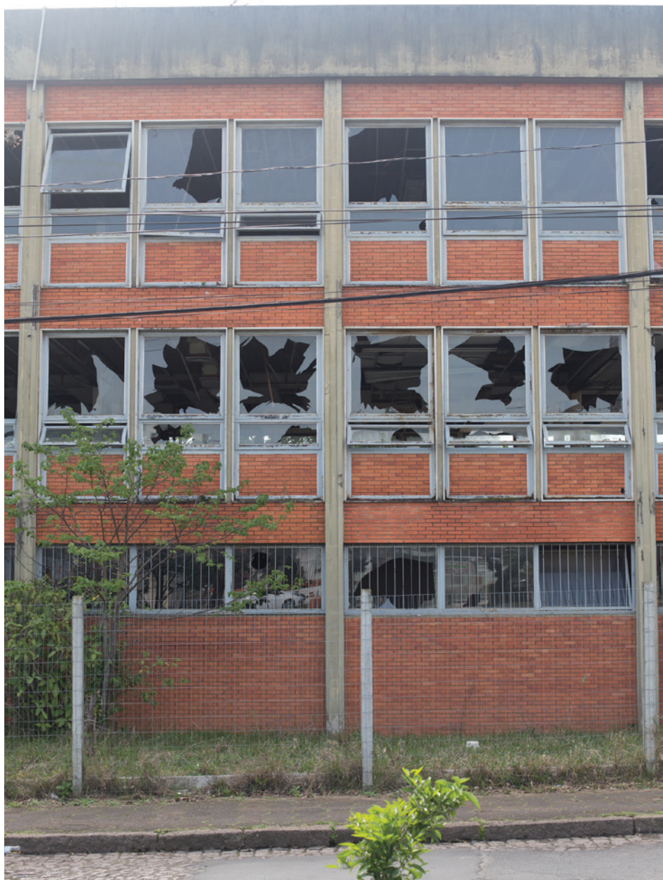
13 Vedações da fachada sul do edifício administrativo
