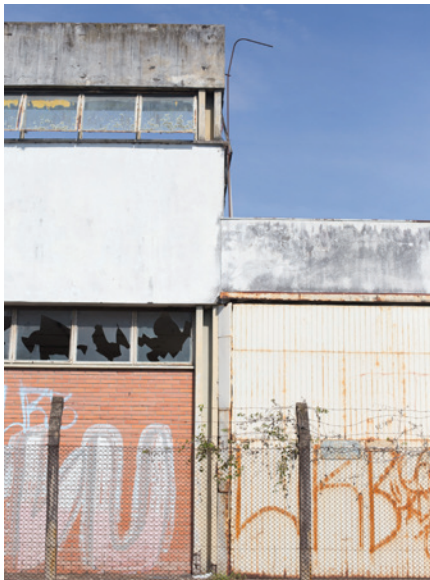
29 Fachadas norte da fábrica de estojos (à esq.) e da câmara de pintura (à dir.)
