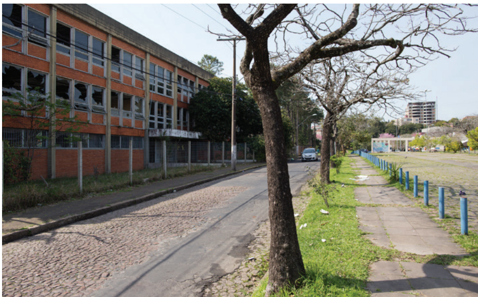
16 Rua entre o edifício administrativo e a praça seca
