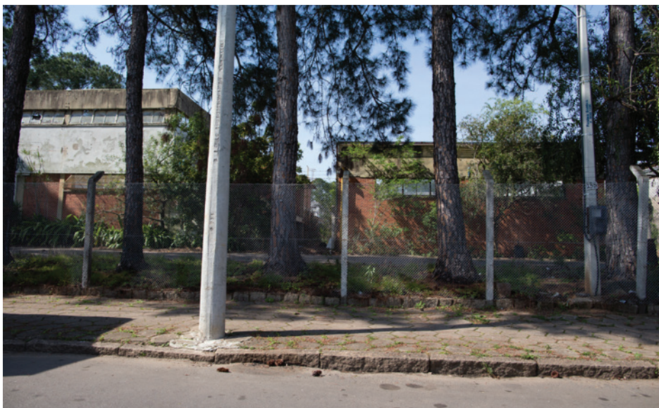
32 Faixa de pinheiros na divisa do terreno e fachadas oeste da fábrica de estojos (à esq.) e de edificação adjacente
