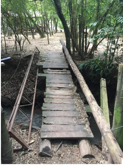
Foto 12 – Ponte no limite leste
