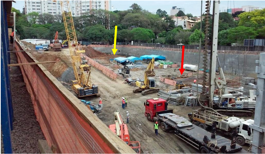
Figura 47 – Canteiro de obras ao término da montagem do Setor 1
