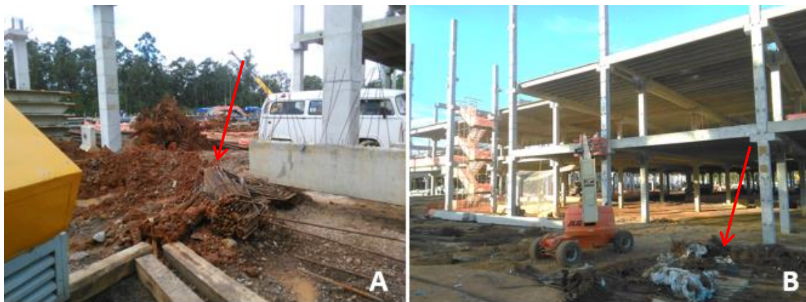
Figura 80 – Armazenamento de aço
