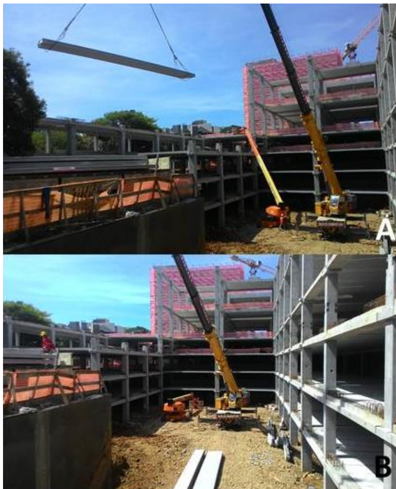
Figura 56 – Atividade de descarregamento de peças no canteiro de obras
