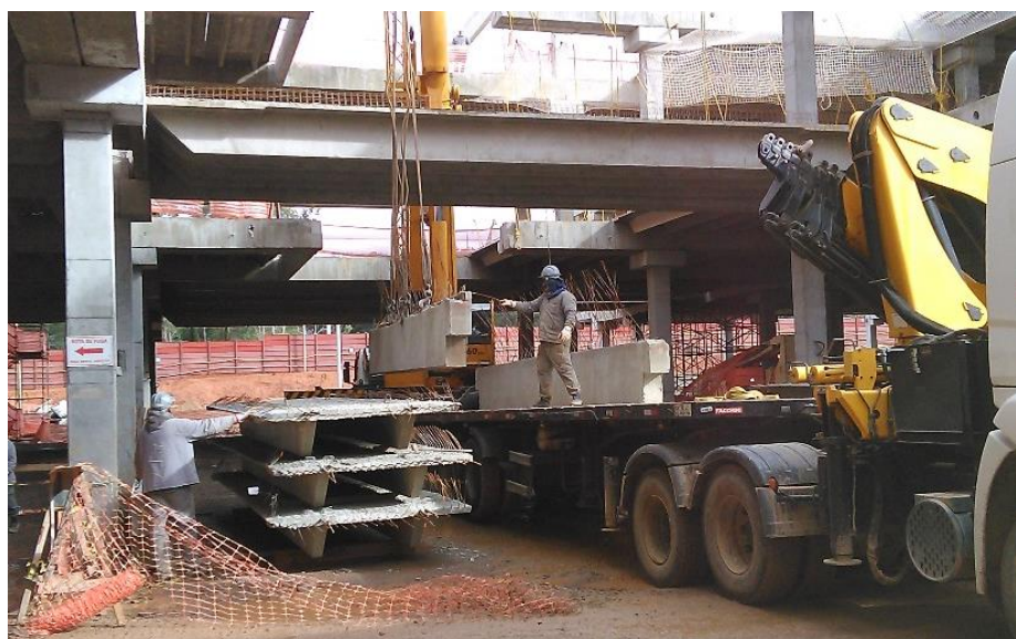
Figura 82 – Transporte das peças para o local de montagem
