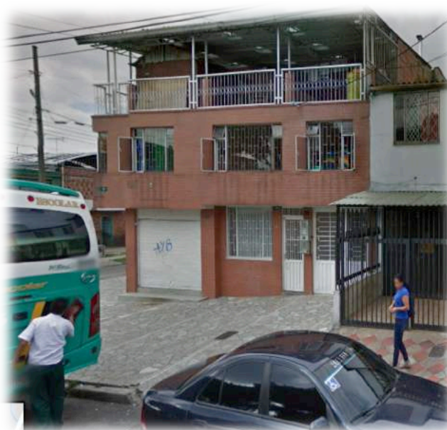
FOTO 4. FACHADA DE LA CPI WAWITA
