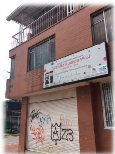
FOTO 3. FACHADA DE LA CPI WAWITA
