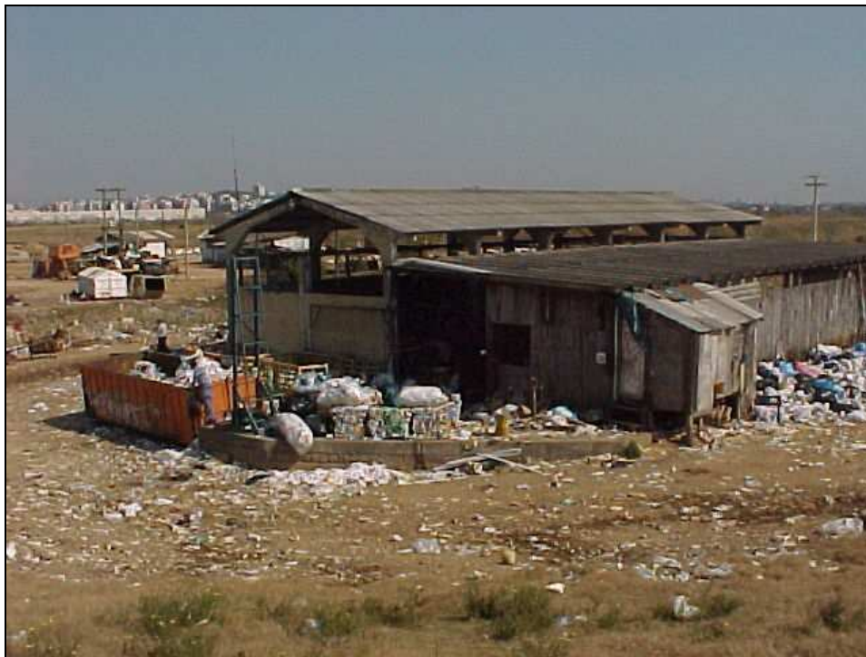
Figura 3.1: Unidade de Triagem Aterro da Zona Norte.
