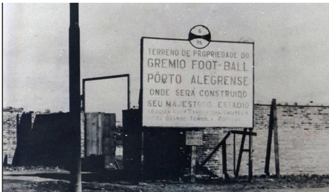
Figura 13: Placa durante a obra do Estádio Olímpico Fonte: Memorial Hermínio Bittencourt
