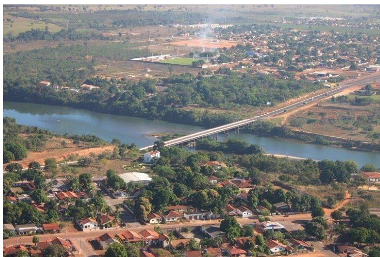
Figura 2 – Ponte sobre o Rio das Mortes
