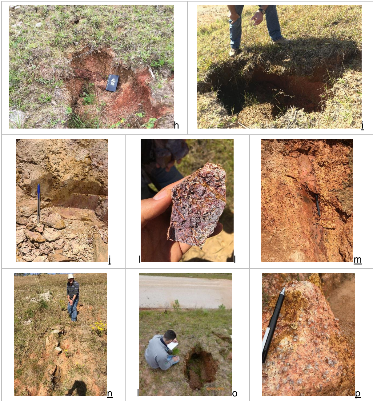
Figura 41: a) Foto aérea do talude. b) Foto aérea de detalhe da ruptura circular. c) Foto aérea das trincas da ruptura. d) Movimento de massa pela ruptura curva. e) Panorâmica frontal do talude rompido. f) e g) Detalhe da superfície de ruptura marcada pela formação de blocos e presença de iluviação no horizonte B. h) e i) Formação de estrutura tipo piping pela infiltração da água da chuva. j), l) e m) diques alterados formados por argila plástica. n) e o) túneis de percolação de água pelas cavernas sub superficiais. p) minerais resistatos de quartzo e k-feldspato centimétrico visíveis na ruptura.
