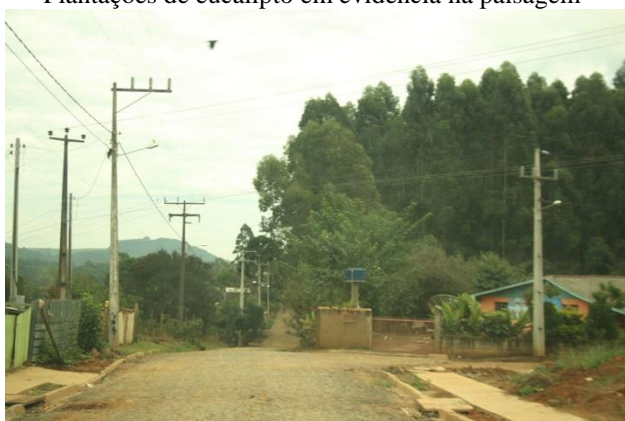
Área de eucalipto no perímetro urbano e próximo à fiação de rede elétrica.
