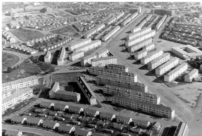
Figura 1 Conjunto residencial Passo d'Areia, Vila IAPI 1952. FONTE: Nick Acervo, 2016.
