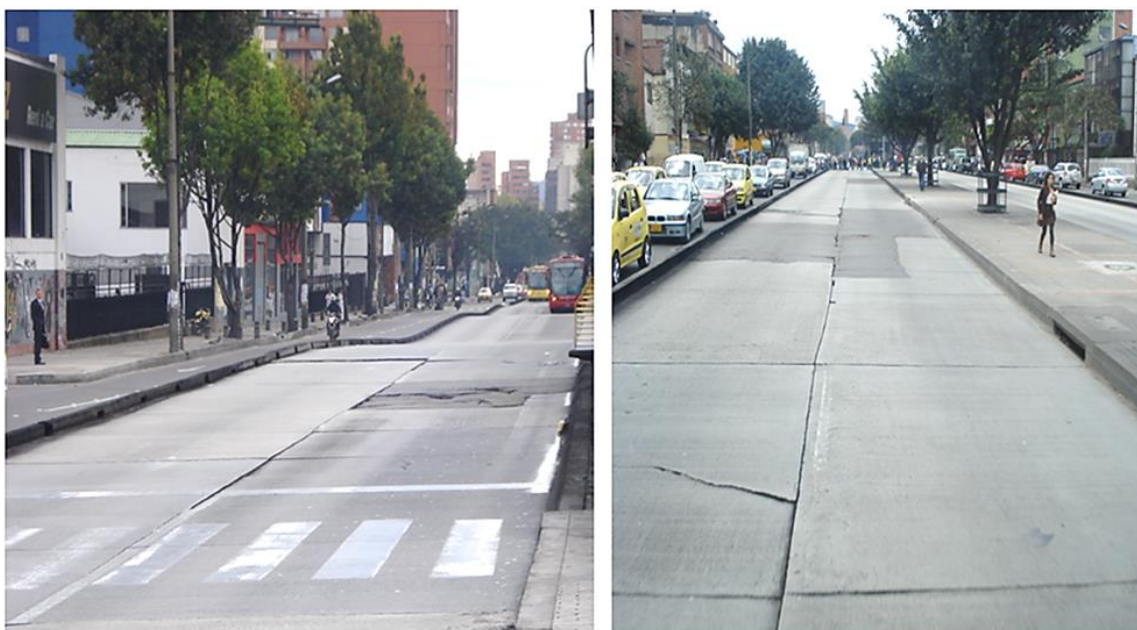
Figura 3.3 - Problema de pavimentação em corredores de transporte coletivos urbanos rápidos. Fonte: A autora.
