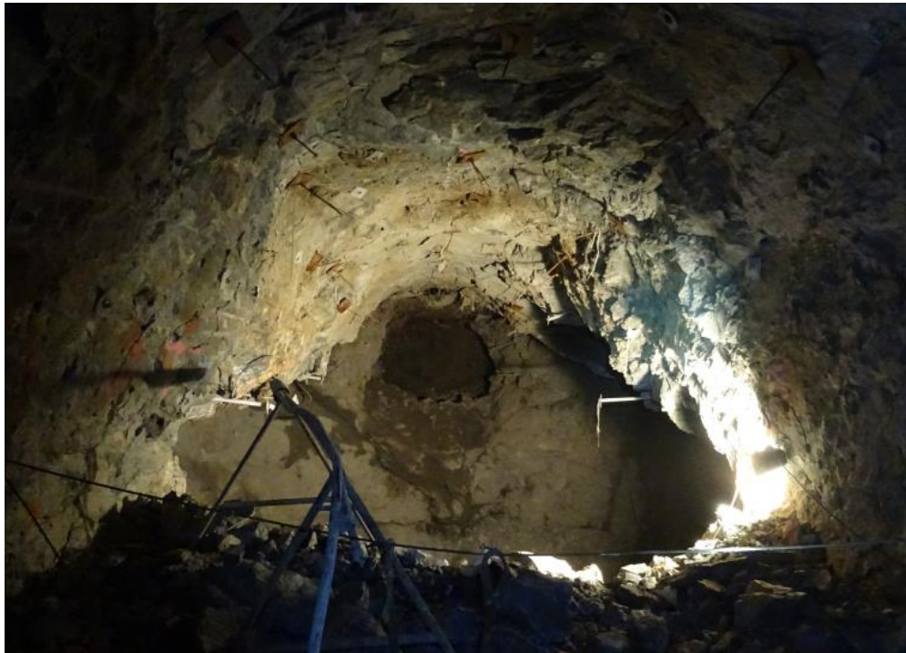
Figura 64 – Foto da câmara TS_N157_E2, demonstrando a preservação dos cabos de teto.
