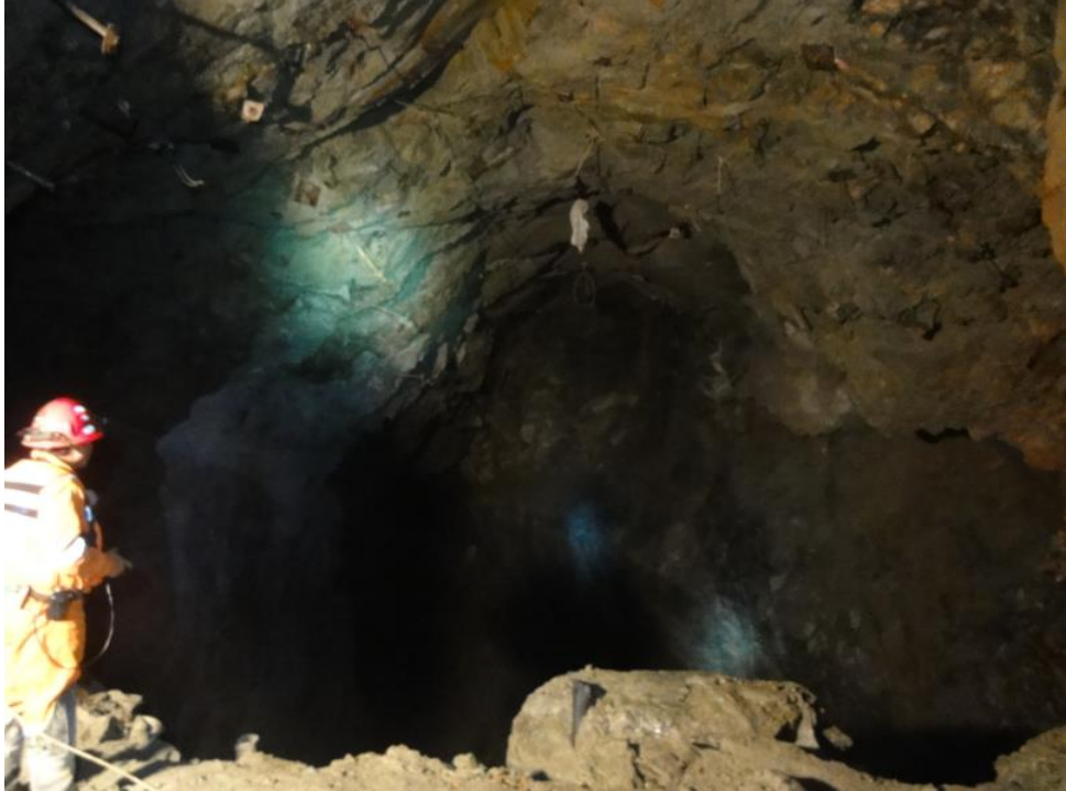
Figura 63 – Foto da câmara TS_N182_E4, demonstrando a preservação dos cabos de teto.
