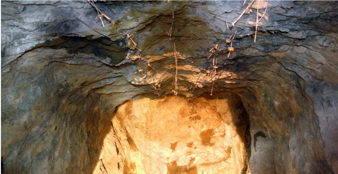
Figura 38 - Foto da câmara TS_N195_E4, terminada, mostrando os danos aos cable-bolts .
