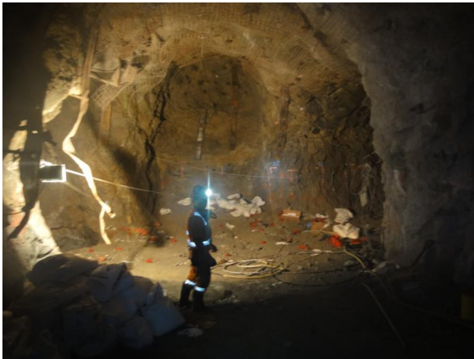
Figura 44 - Exemplo do carregamento de explosivos da fase 2 da câmara, TS_N157_W1.
