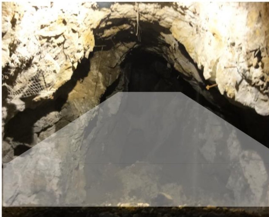
Figura 67 - Foto da câmara TS_N182_E1, demonstrando a preservação parcial da seção da galeria guia, após a abertura da câmara.
