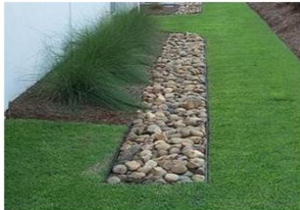
**Figura 7 – Trincheira de infiltração.**
