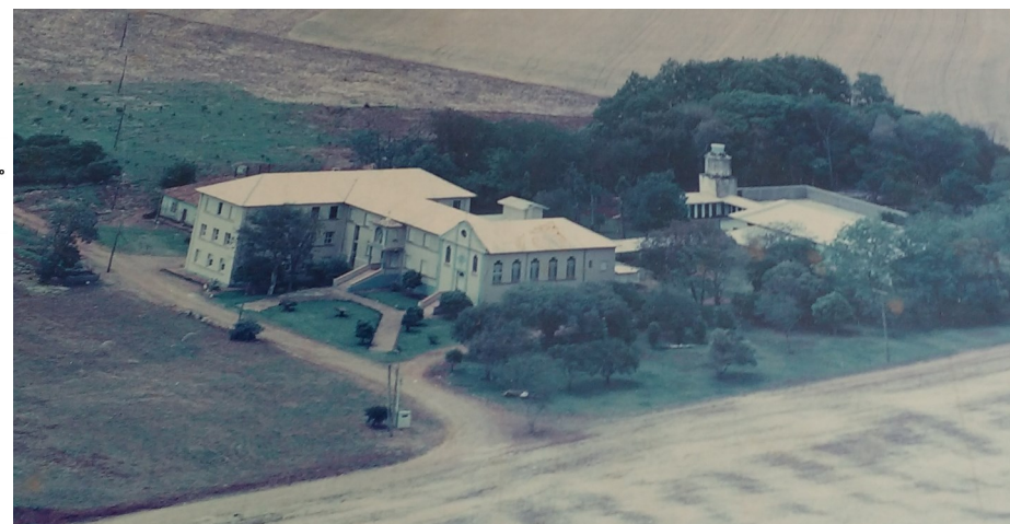
Seminário Sagrado Coração de Jesus. Fonte: Hall de acesso do prédio
