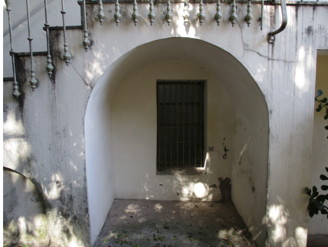
INTERVENÇÕES EM FACHADA - acima janela adicionada e abaixo uma porta retirada e telhado alterado
